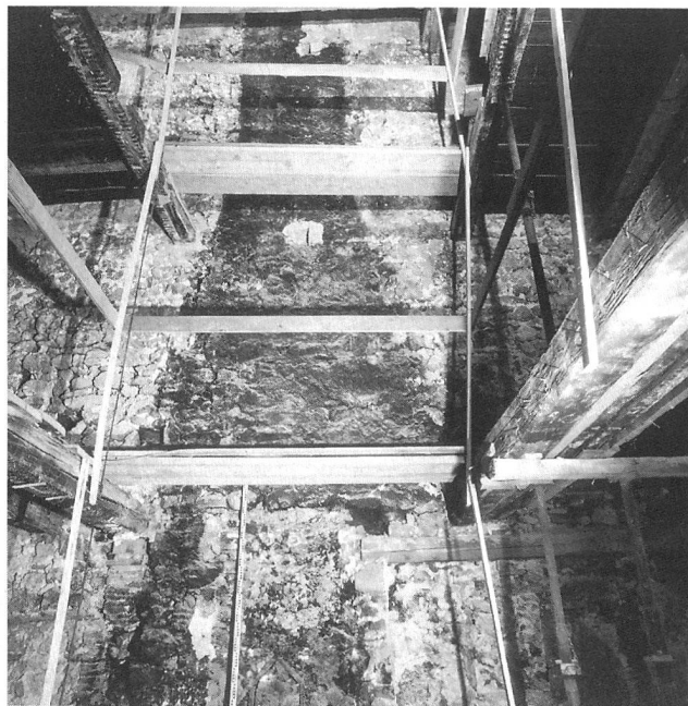
Abb. 12: Biel, Obergässli 5. Ostmauer (14) im 1. bis 3. Obergeschoss mit der Russchwarzung des Kamins, Blick nach Osten.
