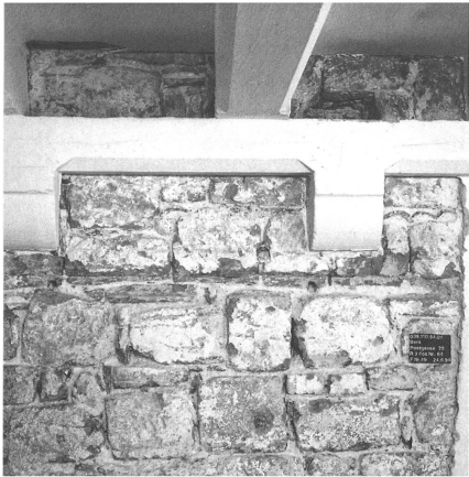
Abb. 25: Die Konsolen und Streifbalken (64) in Raum 2 von Postgasse 70, Blick gegen Osten.
