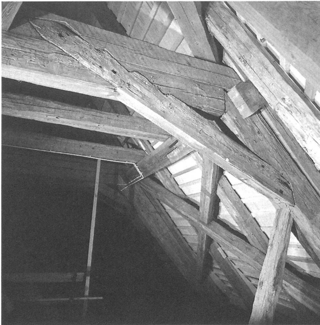
Abb. 15: Kopfhölz eines wiederverwendeten Gebindes aus dem 16. Jahrhundert.
