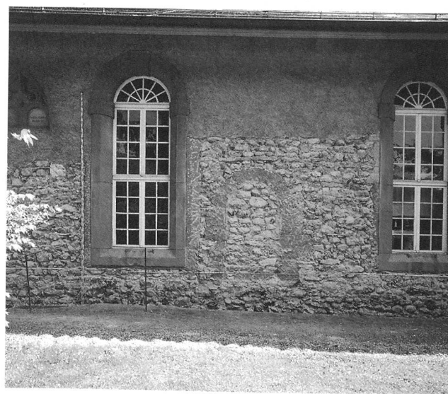
Abb. 61: Bolligen, Kirche. Nordfassade mit vermauertem Rundbogenportal im romanischen Schiff.
