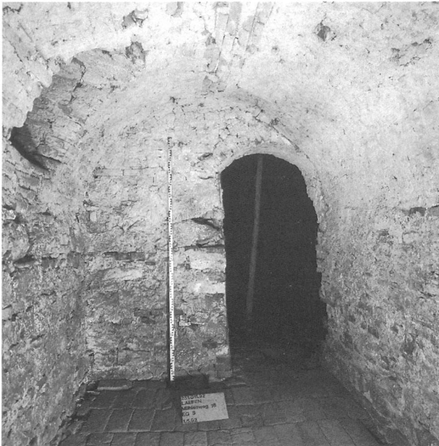
Abb. 124: Laufen, ehem. Ziegelscheune. Innenansicht in die gewölbte Kalkkammer.
