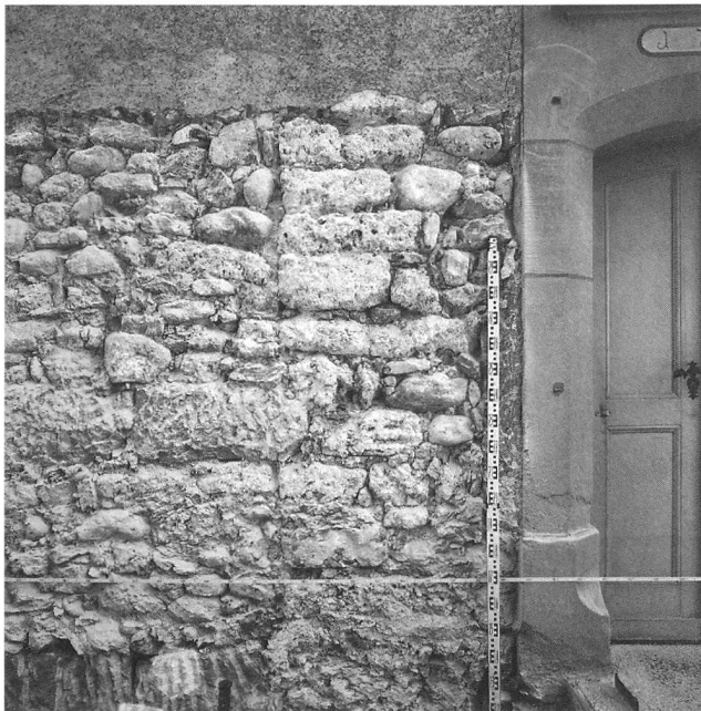
Abb. 62: Bolligen, Kirche. Nordfassade mit der Baunaht zwischen romanischer Chorschulter und barockem Chor.
