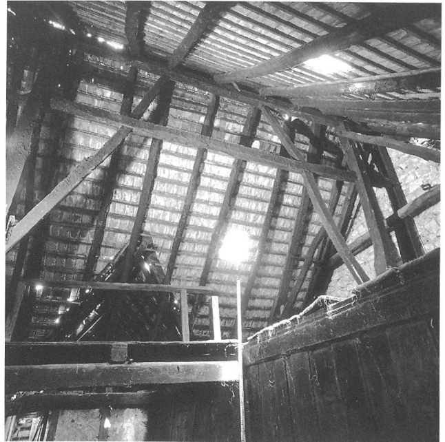
Abb. 150: Niederbipp, Kirchgasse 8. Blick ins Dach mit den Hölzern des Hochstudhauses von 1476.
