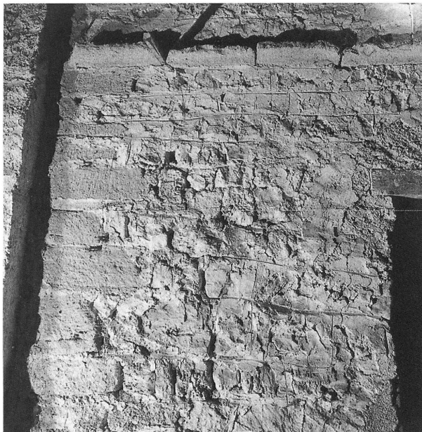
Fig. 11: Jointoyage en pietra rasa, côté est du clocher.
