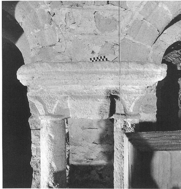
Fig. 10: Baie double, posée sur deux colonnes (2.2.9).
