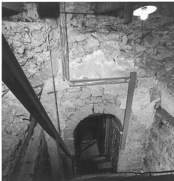
Fig. 8: Entrée du clocher. À droite on voit les restes de l'ancienne voûte.
