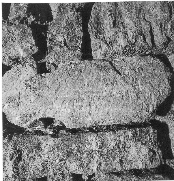
Fig. 6: La réfection du crépis a permis de dégager plusieurs fragments de l'ancienne église, détruite en 1739. Ici un élément d'une voûte gothique.
