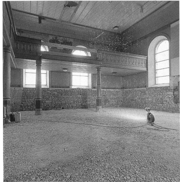
Fig. 5: Vue de l'intérieur vers le sud-est après coffrage pour le nouveau sol, décembre 1991.
