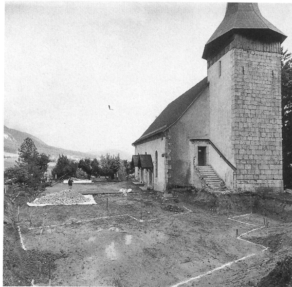
Fig. 1: L'église en cours de restauration, vue du nord, avril 1991.
