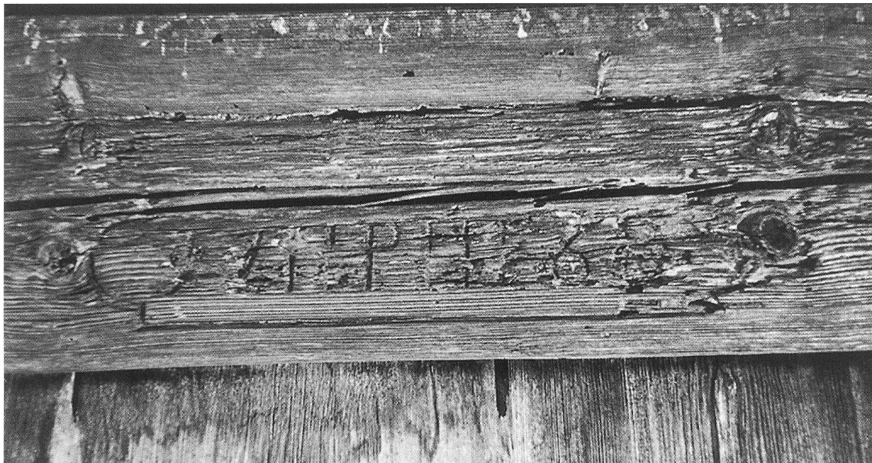
Fig. 14: Façade nord. Inscription sur la corniche de bois: 17 I HP M[?]A[?] 86[év. 88 ou 89?].
