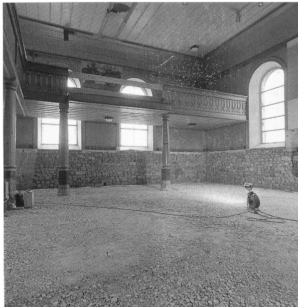
Fig. 5: Vue de l'intérieur vers le sud-est après coffrage pour le nouveau sol, décembre 1991.
