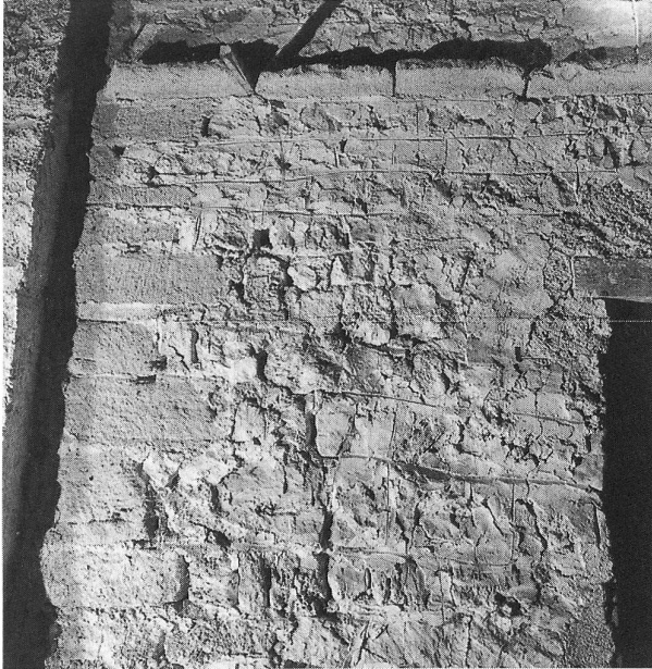
Fig. 11: Jointoyage en pietra rasa, côté est du clocher.
