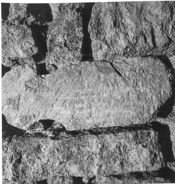
Fig. 6: La réfection du crépis a permis de dégager plusieurs fragments de l'ancienne église, détruite en 1739. Ici un élément d'une voûte gothique.
