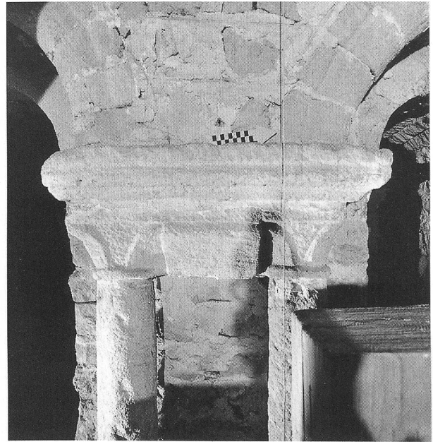
Fig. 10: Baie double, posée sur deux colonnes (2.2.9).
