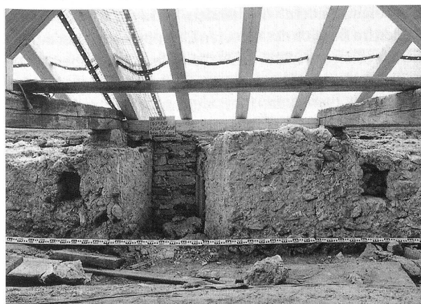
Abb. 14: Korridormauer mit Löchern der Deckenbalken.
