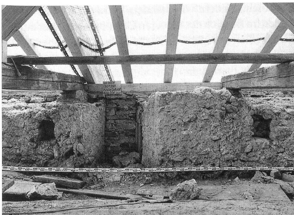
Abb. 14: Korridormauer mit Löchern der Deckenbalken.
