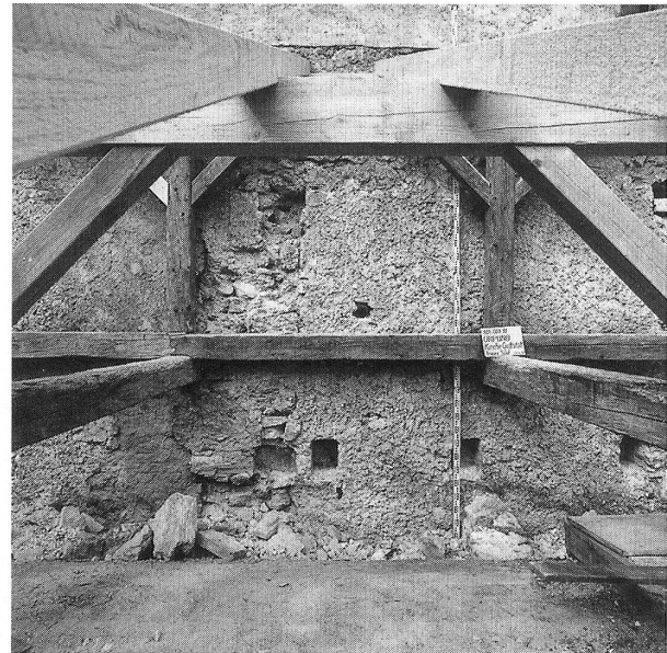
Abb. 12: Kirchenmauer mit Löchern der Konsolen und Deckenbalken, westlicher Stützpfiler.
