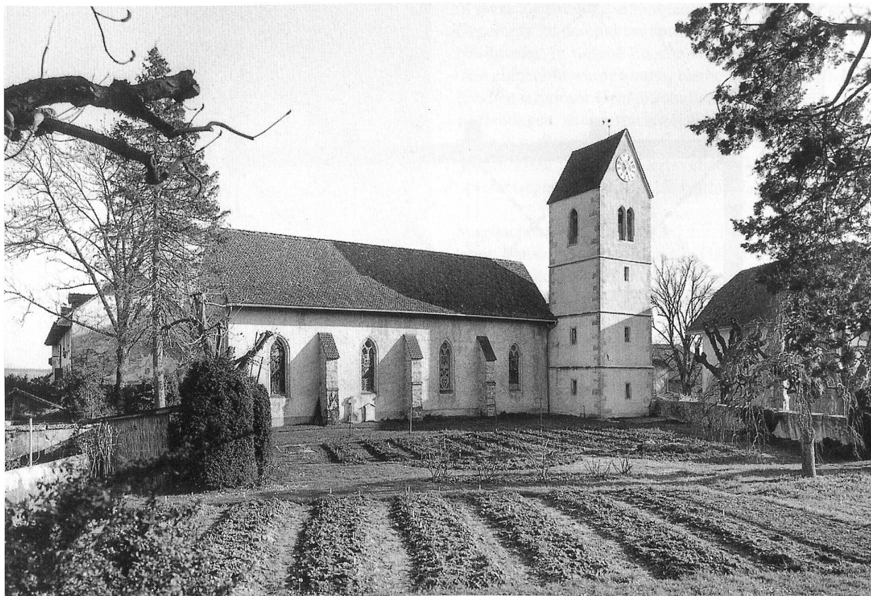
Abb. 20: Die Nordseite der Kirche.
