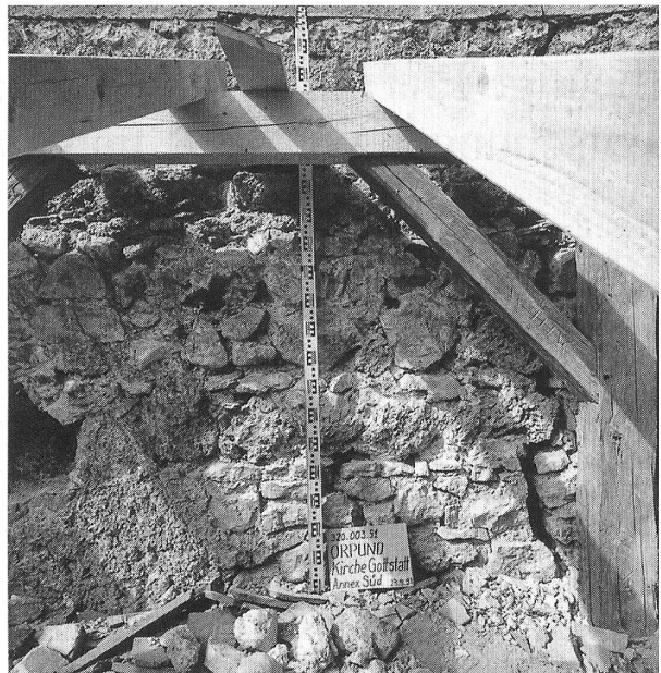
Abb. 3: Mauerwerk der Kirche (Südmauer Obergaden).
