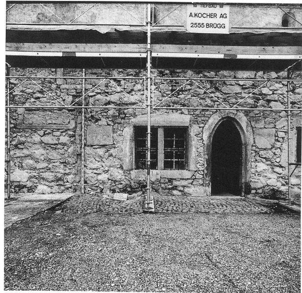
Abb. 17: Fassade der südlichen Korridormauer. Die grossen Sandsteinblöcke bilden die Überreste des zurückgeschroteten Gewölbeansatzes des Kreuzgangs.
