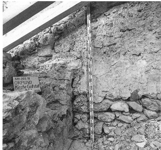
Abb. 7: Die westliche Stirnmauer des Nebengebäudes ist gegen dessen Südmauer gesetzt.
