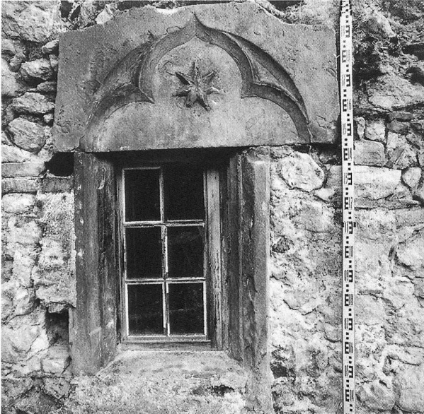
Abb. 18: Fassade der südlichen Korridormauer. Wiederverwendeter Fenstersturz mit Blendbogen.
