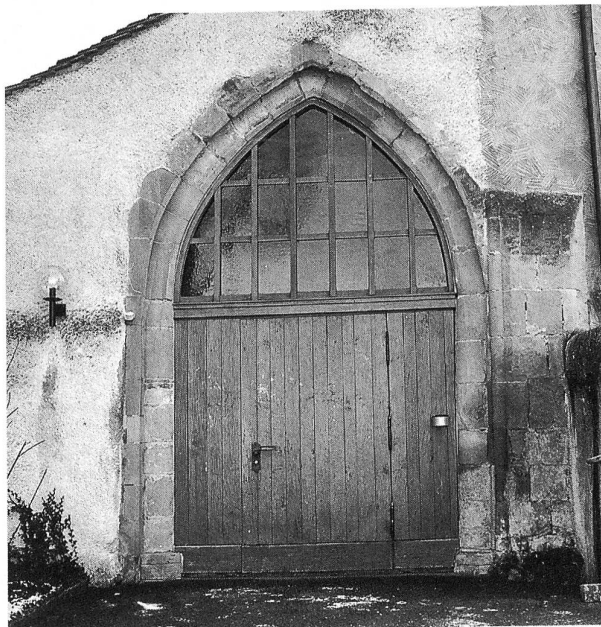
Abb. 24: Arkade in der Ostmauer des Korridors, Ostseite (Aussenseite).
