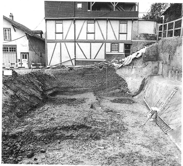
Abb. 2: Blick nach Osten in die offene Baugrube. Im Ostprofil sind deutlich die Kulturschichten erkennbar, welche vom jüngeren Stadtgraben durchschnitten wurden.
