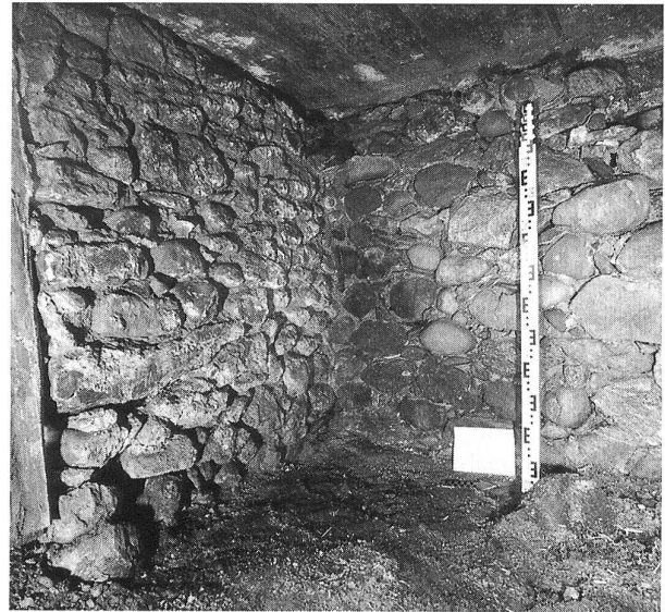
Abb. 4: Einblick in die Südostecke des Kellers U1.
