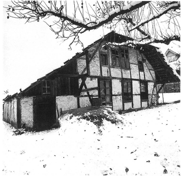
Abb. 1: Bäriswil, Röhrenhütte. Äusseres von Süden, Zustand vor der Restaurierung. Aufnahme 1988.
