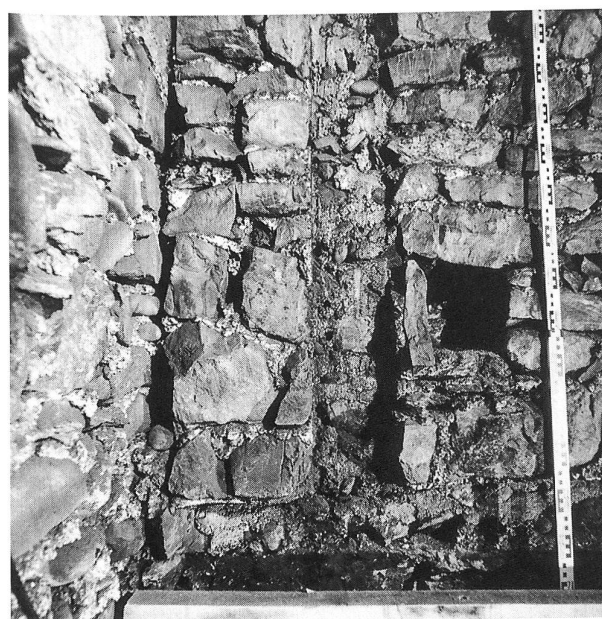
Abb. 425: Thun, Freienhofgasse 20. Westliche Brandmauer. Detail des Anstosses von Mauerwerk (4) an Mauerwerk (2) mit Negativen des älteren Dachstuhls (3).
