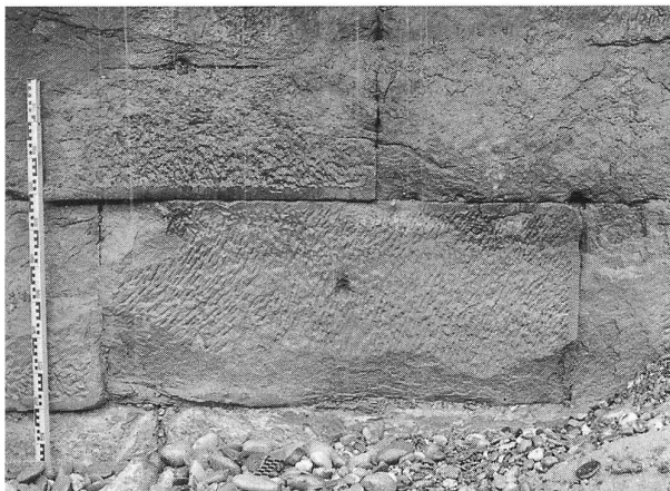
Abb. 155: Bern, Mattenschwelle. Detail der Sandsteinquadermauer.
