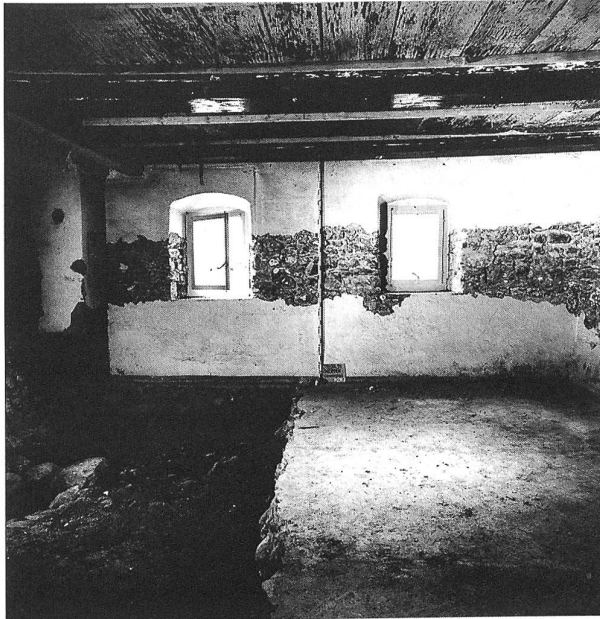
Abb. 508: Zweisimmen, Unterweisungshaus. Inneres nach Osten.
