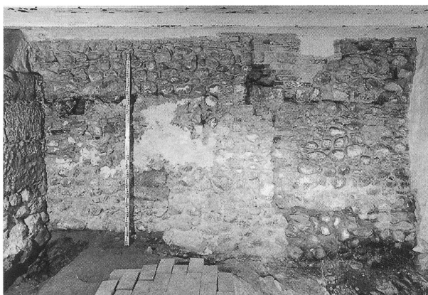
Abb. 317: Laupen, Marktasse 2. Ansicht an die Stadtmauer im Kellerbereich. Deutlich sichtbar ist die horizontale Baunaht für die Unterfangung.
