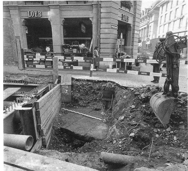
Abb. 168: Bern, Schauplatzgasse. Sandsteinkanalfund. Detail.
