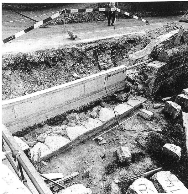
Fig. 416: Saicourt, Bellelay, mur de soutènement sud. Extrait avec le nouveau mur de soutènement en béton et en dessous le mur (2); à droite, restes du mur (3) et sous la route, le mur (1). Vue vers le sud-ouest.
