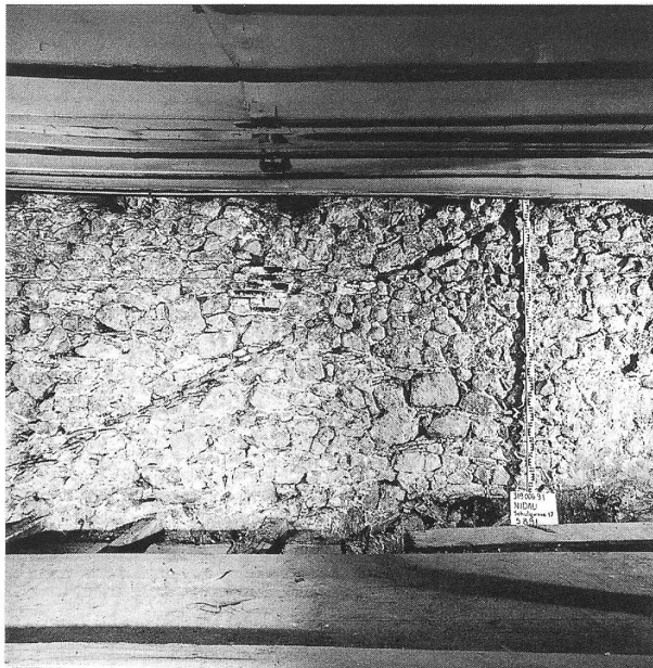
Abb. 391: Nidau, Schulgasse 17. Ausschnitt der westlichen Brandmauer mit Dachlinie von Mauer (15) im 2. Obergeschoss.
