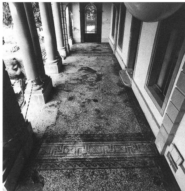
Abb. 342: Muri, Mettlengut. Übersicht der Befunde nach Westen.
