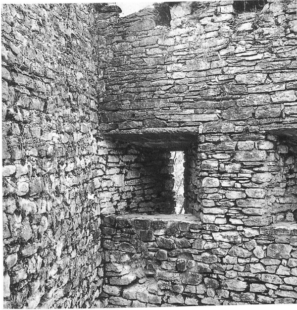
Abb. 474: Wilderswil, Unspunnen. Mauerzustand 1986. Ausbrechende Teile der Schale am Oberen Palas 1986.
