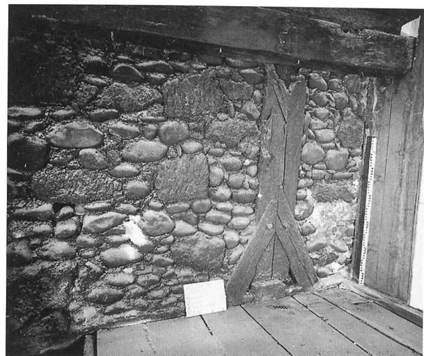
Abb. 312: Laupen, Kreuzplatz 1. Mauerwerk der Phase IV (Brandmauer Nordost) mit Ummantelung eines Ständers mit Fussbalken der Phase III.
