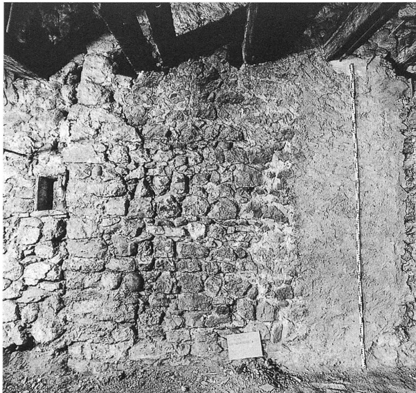
Fig. 351: La Neuveville, Rue du Beauregard 16. Rez-de-chaussée mur (2).
