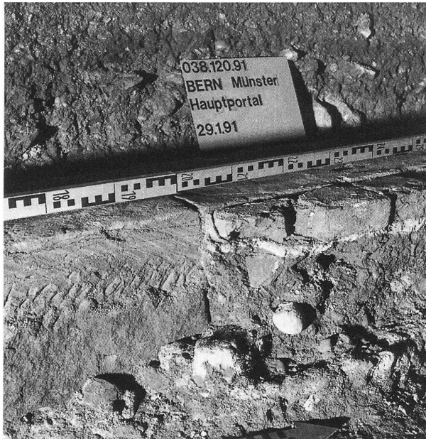
Abb. 161: Bern, Münsterportal. Sandsteinschwelle mit Abtreppung zur Aufnahme der abschliessenden Tonplatten.
