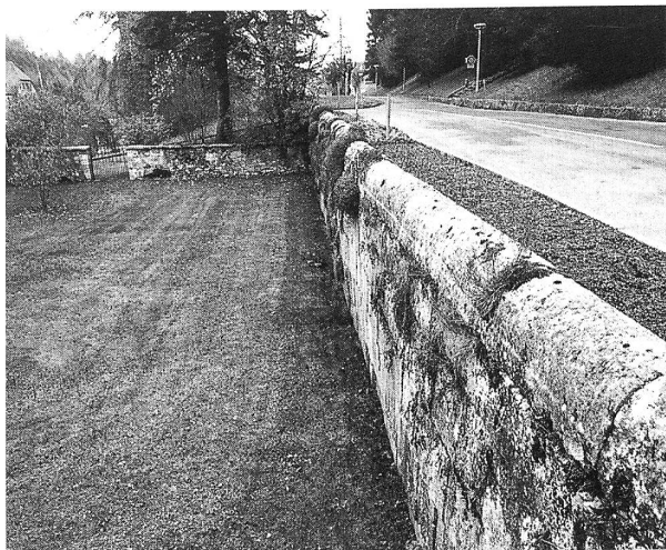
Fig. 415: Saicourt, Bellelay, mur de soutènement sud. Etat de la moitié est avant la réfection.
