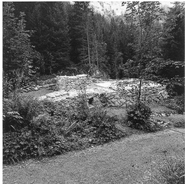
Abb. 325: Lauterbrunnen, Trachsellauenen. Die konservierte Verhüttungsanlage 1994.
