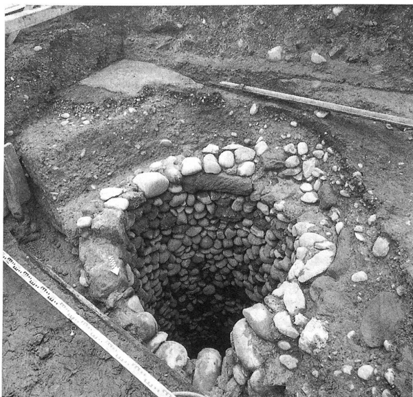
Abb. 242: Koppigen, Hauptstrasse 33. Der offene Sodbrunnen nach Entfernung der Platte.
