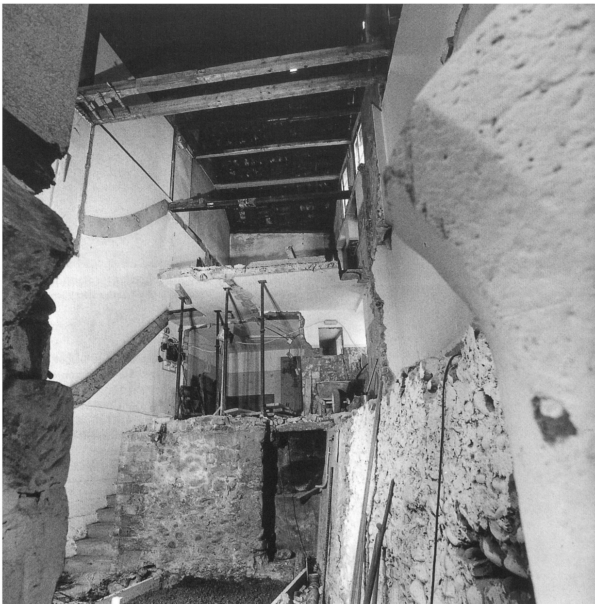
Abb. 315: Laupen, Marktgasse 4. Teilausgekerntes Inneres. Im Vordergrund der Bogenansatz des Einganges von 1520.
