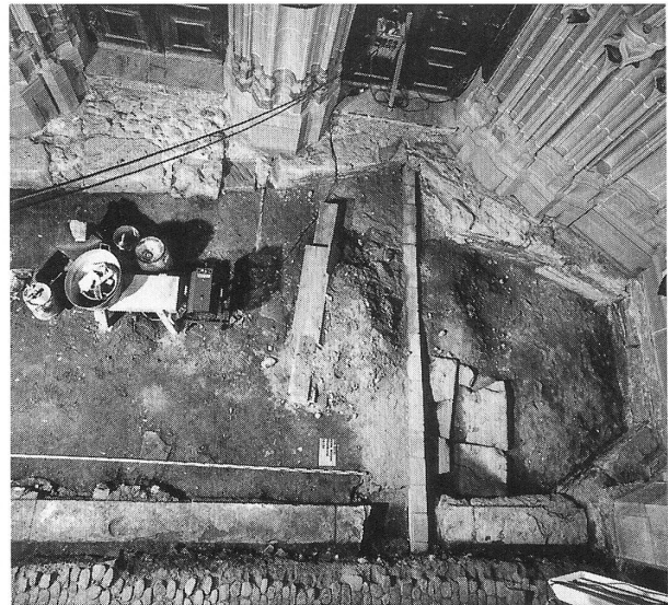
Abb. 159: Bern, Münsterportal. Übersicht der Grabungen.
