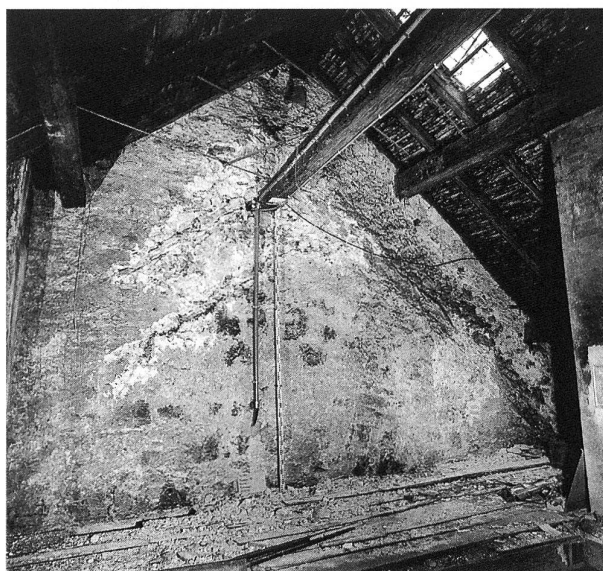
Abb. 381: Nidau, Hauptstrasse 17. Übersicht im Dachstuhl nach Nordosten.
