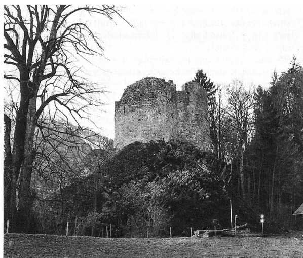
Abb. 471: ...und nach der Sanierung und Felsreinigung 1993.
