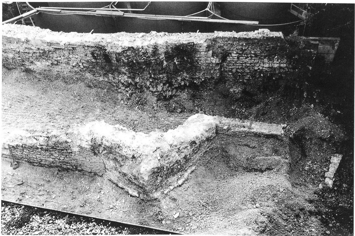
Abb. 515: Zwingen, Schloss 1990. Baugrube mit Grabenmauern nach Südwesten.
