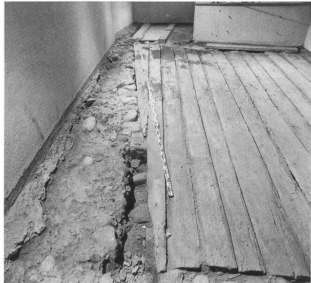
Abb. 318: Laupen, Marktasse 4. Die Abbruchkronen der zur Vergrösserung des Raumes zurückgeschroteten Stadtmauer. Blick nach Nordosten.
