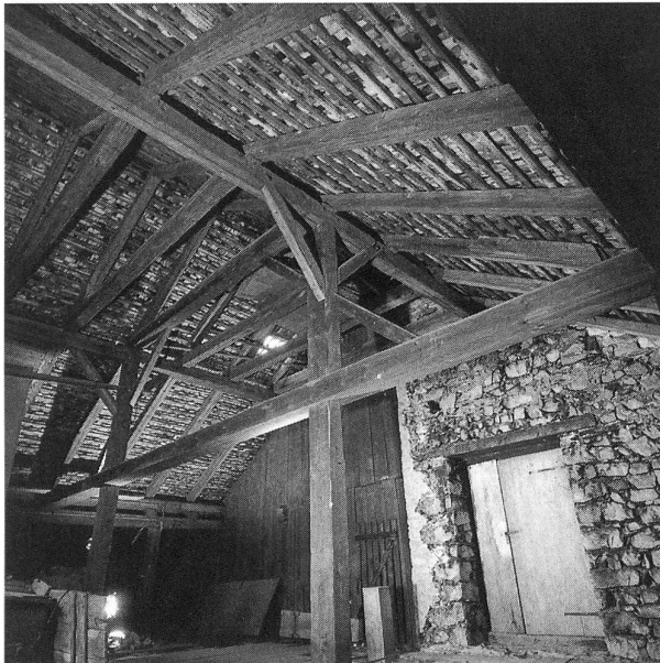
Abb. 223: Hilterfingen, alte Thunstrasse 36. Ansicht der nördlichen Giebelmauer.
