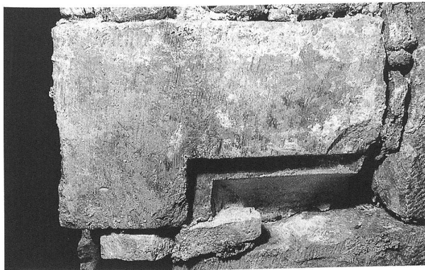
Fig. 360: La Neuveville, Rue du Collège 21. Remploi de fenêtres dans la maçonnerie.
