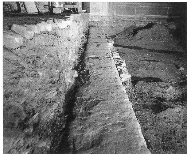
Abb. 160: Bern, Münsterportal. Die freigelegte originale Schwelle nach Norden. Deutlich sichtbar sind die durchgehenden Ablaufspuren: Beweis, dass das Portalgitter erst nach längerer Benützungszeit erstellt worden sein kann. Links Anschluss des heutigen Münsterplatzes mit aktueller Pflasterung.
