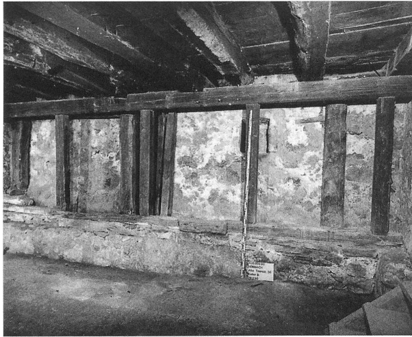
Abb. 216: Befunde im Keller nach Norden.
