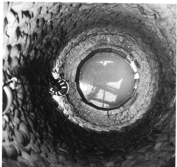
Abb. 245: Koppigen, Hauptstrasse 33. Blick im Sodbrunnen nach unten. Deutlich sichtbar ist der einglassene Bottich.
