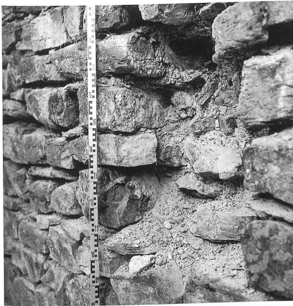
Abb. 475: Wilderswil, Unspunnen. Ausbrechende Mauerschale an der Westwand des Oberen Palas. Zustand 1986.
