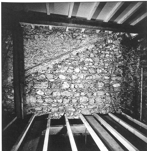
Abb. 424: Thun, Freienhofgasse 20. Südliche Brandmauer: Wechsel von Mauerwerk (2) zu Mauerwerk (4).
