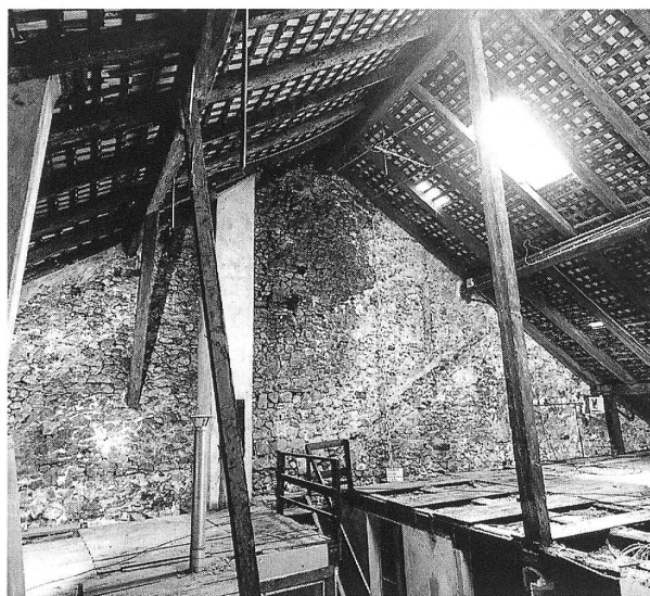
Abb. 394: Nidau, Schulgasse 17. Dachraum nach Südwesten.
