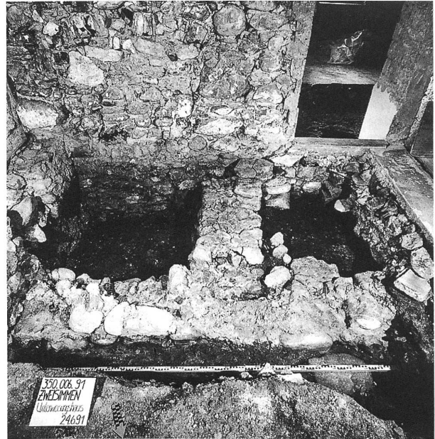
Abb. 510: Zweisimmen, Unterweisungshaus. Ofenfundament (7).
