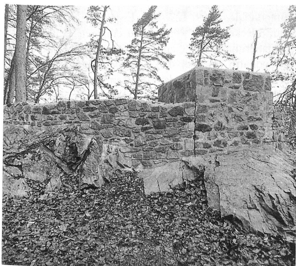
Abb. 336: Matten, Galgen. Pfeilerdetail nach Konservierung.
