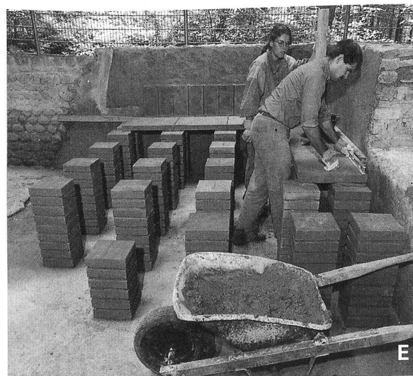
Abb. 63: Bern-Engelhalbinsel - Römerbad, Rekonstruktionen 1995/96. A Holzboden der Portikus und Eingangsschwelle ins Apodyterium, B Holzboden im Apodyterium (vorne) und Plattenboden im Frigidarium (hinten), C Piscina, D Präfurium (vorne rechts) sowie Caldarium und Tepidarium (hinten), E-F Rekonstruktion des Hypokaustes im Bereich des Tepidariums.
