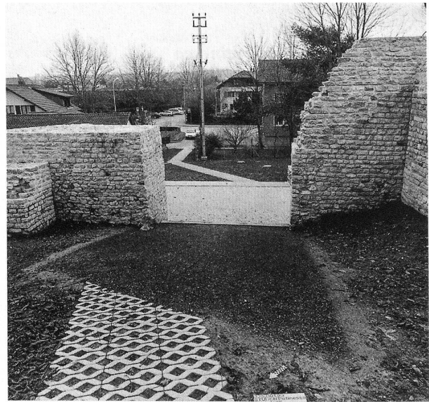
Abb. 119: Studen - Grabefeld / Petinesca 1993–96. Sanierungsetappe 1996. Der heutige Fussweg (Rasengittersteine, links) führt vom Rebenweg durch den Torturm in die Talebene (Worbenstrasse, Nähe Busstation Petinesca ). Im Eingangsbereich des Torturmes ist die hier beobachtete römische Strasse mit einem grauen Kalksplinterbelag angedeutet. Blickrichtung Südosten.
