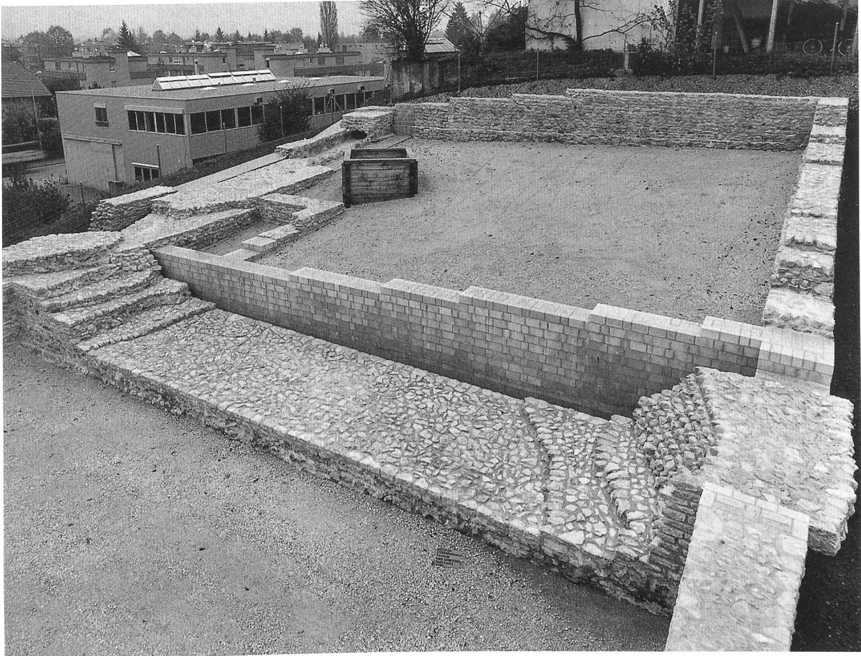
Abb. 117: Studen - Grabefeld / Petinesca 1993–96. Sanierungsetappe 1995. Die Innenfläche des hangwärtigen Gebäudetraktes ist mit beigem Mergelsplinter gekennzeichnet. Er ist sowohl während der jüngeren als auch in der älteren Steinbauphase durch eine Quermauer unterteilt (breite Kalksteinmauer der 2. Bauphase bzw. neue Kalksandsteinmauer der 1. Bauphase). Das Gelniveau lag auch in römischer Zeit auf verschiedenen Ebenen. Blickrichtung Süden.
