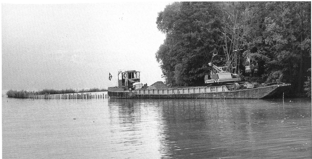
Abb. 30: Sutz-Lattringen - Sutz Rütte V. Rettungsmaßnahmen 1997/98. Ein Teil der Lahnung ist im Sommer 1998 bereits errichtet, und die eingelegten Weidenbündel haben ausgeschlagen (links im Bild); der südliche Teil muss noch fertiggestellt werden. Ausserhalb der Wellenbrecher, welche die erhaltene Kulturschicht «umzäunen», wird das Ufer mittels einer Kiesschüttung geschützt (Kiesschiff rechts im Bild).
