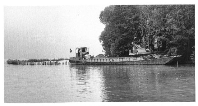
Abb. 30: Sutz-Lattrigen - Sutz Rütte V. Rettungsmassnahmen 1997/98. Ein Teil der Lahnung ist im Sommer 1998 bereits errichtet, und die eingelegten Weidenbündel haben ausgeschlagen (links im Bild); der südliche Teil muss noch fertiggestellt werden. Ausserhalb der Wellenbrecher, welche die erhaltene Kulturschicht «umzäunen», wird das Ufer mittels einer Kiesschüttung geschützt (Kiesschiff rechts im Bild).
