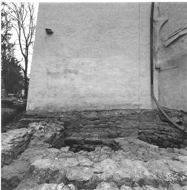
Abb. 24: Ostseite des Turmes mit Baunaht gegen die jüngere Chorschulter, den hochliegenden Kragstein. Oben rechts der Ansatz der ersten rundbogigen Blendarkade der Apsis.
