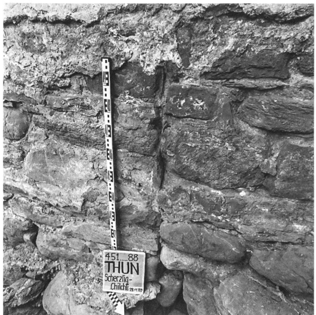
Abb. 26: Nordostecke des Turms mit Pietra-rasa-Verputz sowie mehreren Kalktünchen. Diese setzen sich hinter der Anstoßfuge fort.
