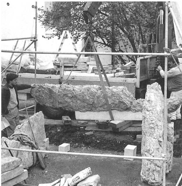
Abb. 21: Laufen - Dolmengrab. Wiederaufstellung 1991. Die West- und die Ostplatte stehen bereits. Jetzt wird die Südplatte mit dem Kran in die richtige Lage gebracht.
