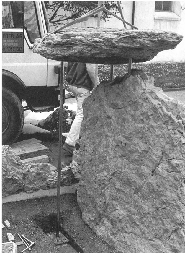
Abb. 22: Laufen - Dolmengrab. Wiederaufstellung 1991. Die (postulierte) Deckplatte wird mittels Kran auf die vorbereiteten Chromnickelstahl-Träger aufgesetzt und fixiert.
