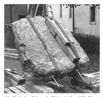
Abb. 20: Laufen - Dolmengrab. Wiederaufstellung 1991. Die mit Chromnickelstahl-Stäben versehene Westplatte wird in die dafür vorgesehenen Bohrlöcher im Magerbeton-Untergrund eingesetzt.
