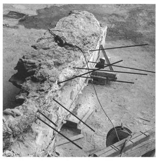
Abb. 17: Laufen - Dolmengrab. Restaurierung 1990/91. Südplatte (11). Zur Festigung werden an der Unterseite Chromnickelstahl-Stäbe eingelassen, ...
