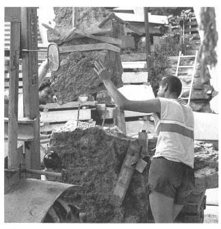
Abb. 16: Laufen - Dolmengrab. Restaurierung 1990/91. Ostplatte (10). Die zwei grossen Plattenteile werden durch zwei eingelassene Chromnickelstahl-Stäbe zusammengehalten.
