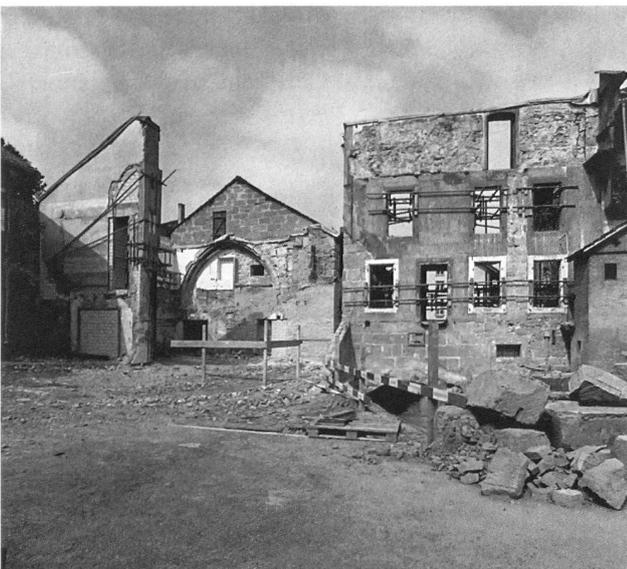
Abb. 265: Burgdorf, Altes Schlachthaus. Die Baureste des ehemaligen Niederspitals nach Abbruch der Schweineschlächtereier. Links das halbe Chorfenster, in der Mitte der Chorbogen, rechts der durch ein Gebäude überbaute Mühlebach.
