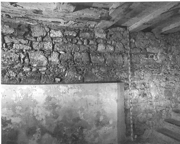
Abb. 196: Aarberg, Stadtplatz 43. Mauercharakter des Erdgeschosses an südlicher Brandmauer.
