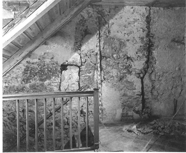
Abb. 198: Aarberg, Stadtplatz 43. Blick an die Baunaht in der südlichen Brandmauer: Anstoss an die später durchbrochene Stadtmauer (rechts).
