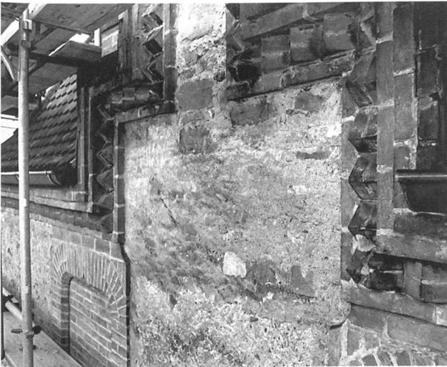
Abb. 347: Oberhofen, Schloss. Die Pourtalèsschen Ausbauten zeugen von hoher Qualität an aufwendiger Backsteintechnik. Treppengiebel-detail der Ostseite.
