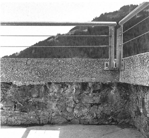
Abb. 294: Frutigen, Tellenburg. Detail der Mauerbekrönung nach der Sanierung.
