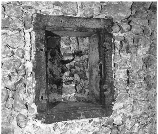
Abb. 252: Büren a.A., Hauptgasse 27. Wandresor in der östlichen Brandmauer.
