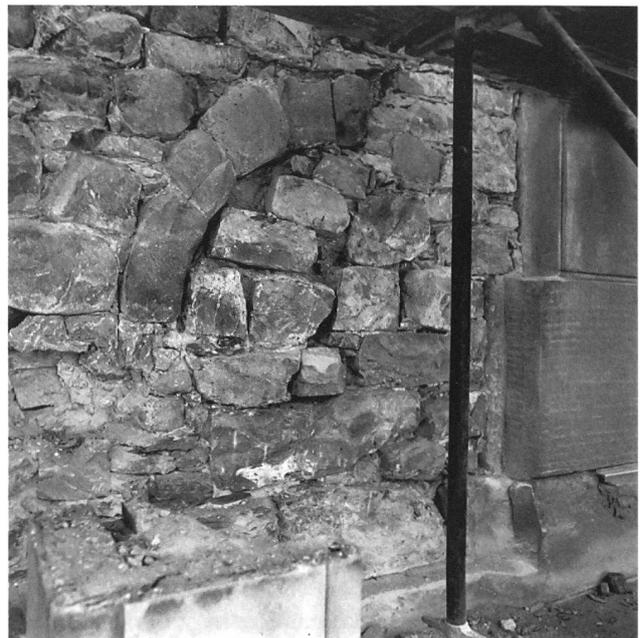
Abb. 342: Oberhofen, Schloss. Überrest des originalen Hocheinganges in den zentralen Turm. Starke Brandrötungen zeugen von einem verheerenden Feuer.
