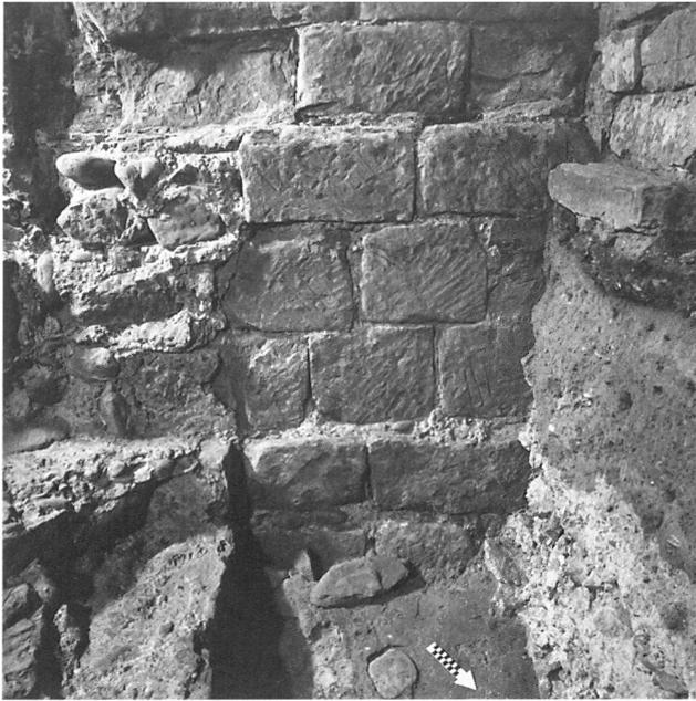
Abb. 270: Burgdorf, Altes Schlachthaus. Mauerdetail des ersten Kirchenbaus (3). Blick an die innere Südostecke. Sandsteinquader mit Schichthöhenzeichen.
