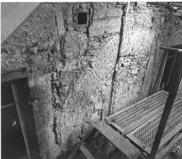
Abb. 225: Bern, Gerechtigkeitsgasse 80. Zugemauerte Arkade im Erdgeschoss.
