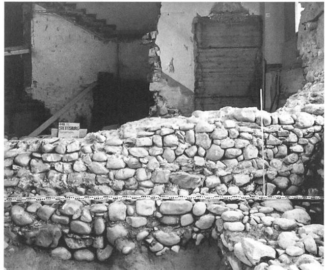
Abb. 363: Steffisburg, Burgerheim. Über einem Rücksprung (Meter) auf den Resten der Mauern des ersten Steinbaus aufsitzen die Innenmauern des heutigen Baus. Der Mauercharakter zeigt, dass der Bau von 1769 weitgehend mit Abbruchmaterial des mittelalterlichen Vorgängers errichtet worden ist. Blick nach Süden.
