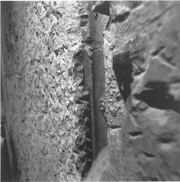
Abb. 223: Bern, Gerechtigkeitsgasse 80. Abgeschrotetes Fensterdetail am gotischen Kernbau.
