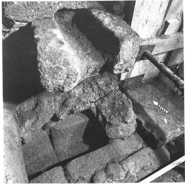
Abb. 206: Bern, Aarberggasse. Wasserleitung (oben) und Ehgrabenführung (unten) im Bereich der Brücke westlich des Golattenmatttores.
