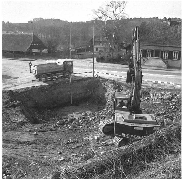
Abb. 330: Mühleberg, Gümnenen. Baugrube des Restaurants Kreuz mit Holzbrücke im Hintergrund. Im Profil unter dem Lastwagen sind die dicken Kiespakete der Verlandung einer ehemals hier vorhandenen Bucht der Saane festzustellen.
