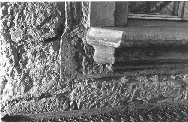
Abb. 224: Bern, Gerechtigkeitsgasse 80. Barock umgearbeitetes gotisches Fensterbankprofil im 2. Obergeschoss.
