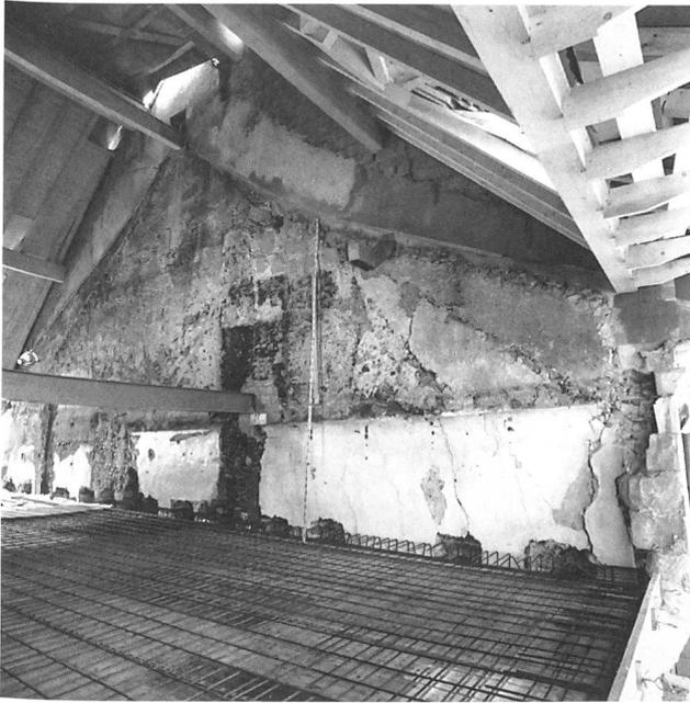
Abb. 188: Aarberg, Stadtplatz 3. Nördliche Brandmauer im Giebelbereich mit Spuren älterer Bauten.
