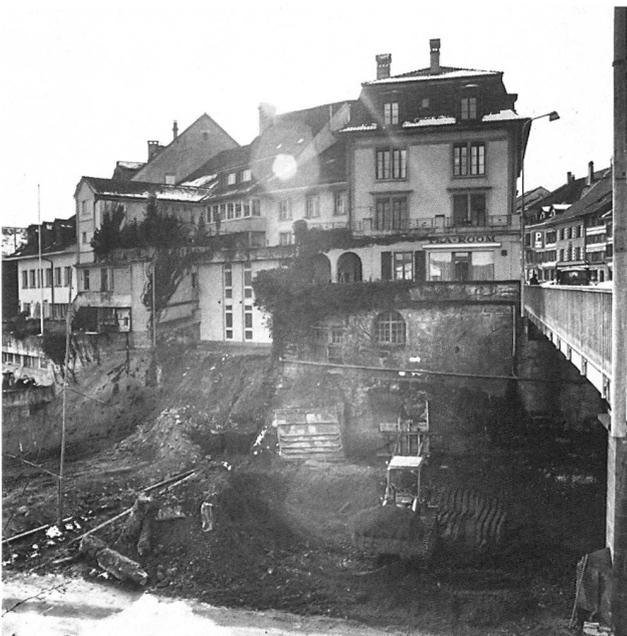
Abb. 185: Aarberg, Stadtplatz 1/3. Stadtseitiger Brückenkopf mit Baugrube für die Tiefgarage.
