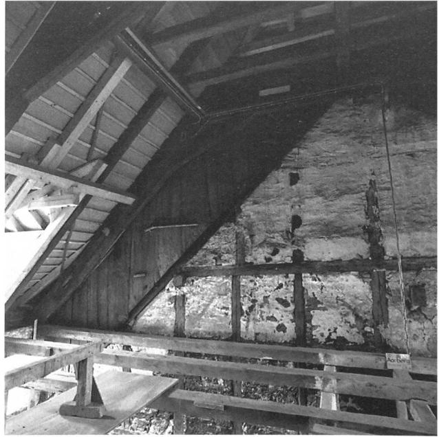
Abb. 193: Aarberg, Stadtplatz 22. Brandmauer West im Dachgeschoss mit älteren Bauspuren der Phasen II, III, V (Verbretterung erhalten) und VI.
