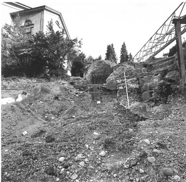
Abb. 275: Burgdorf, Schmiedenrain. Nordrand der Baugrube. V.r.n.l.: Strassenkofferungen und -Pflasterungen des älteren Schmiedenrains, Stützmauer, Baureste des barocken Baus mit Gewölbekeller.
