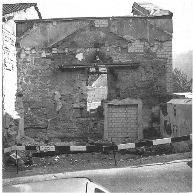
Abb. 266: Burgdorf, Altes Schlachthaus. Südfassade des Chors mit originalem Fenster. In der Sockelmauer rechts verbirgt sich ein Überrest der Stadtmauer.
