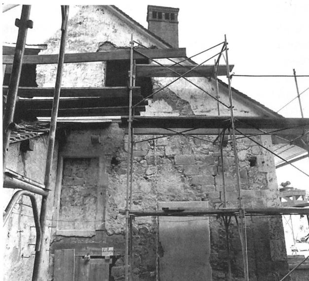
Abb. 197: Aarberg, Stadtplatz 43. Die Baubefunde der südlichen Brandmauer von aussen. Die Aufstockung der Phase III hebt sich mit den Sandsteinquadern deutlich ab.
