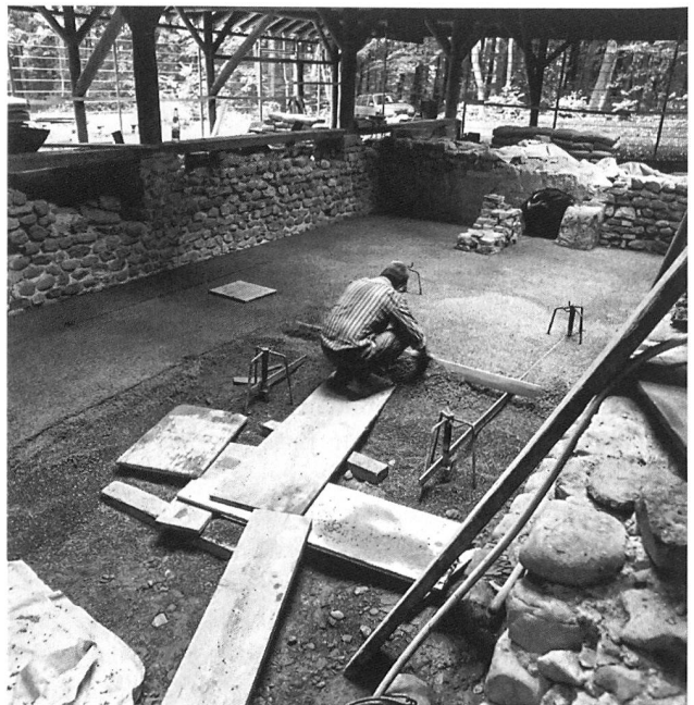
Abb. 89: Bern-Engehalbinsel - Römerbad 1993. Einbringen des Mörtels aus Rundkies und hydraulischem Kalk im Caldarium.
