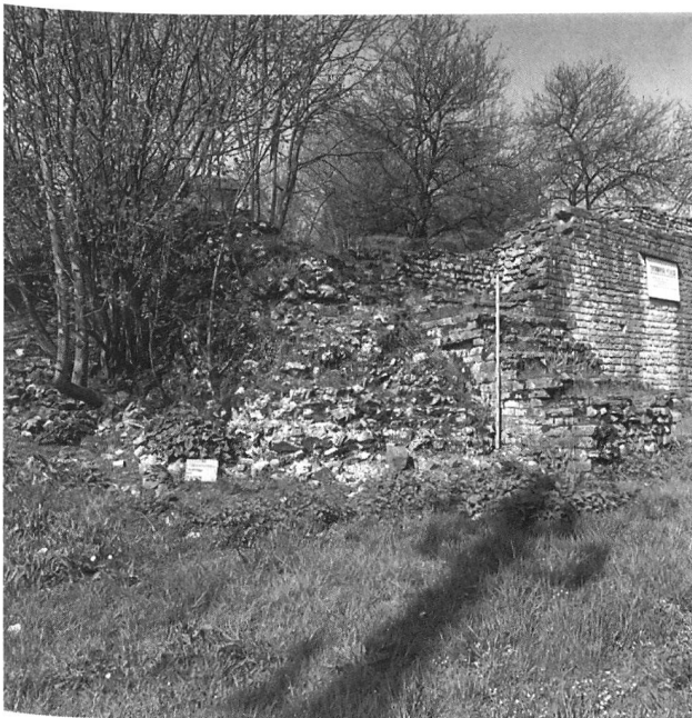
Abb. 154: Studen - Grabfeld / Petinesca. Zustand der «Toranlage» im Winter 1993. Die mächtige Aussenmauer ist vom Wurzelwerk eines Hasel- und Eschenbewuchses durchzogen und zerfällt immer mehr. Blickrichtung Nordwesten.
