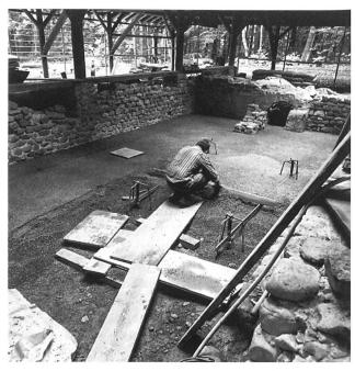
Abb. 89: Bern-Engehalbinsel - Römerbad 1993. Einbringen des Mörtels aus Rundkies und hydraulischem Kalk im Caldarium.
