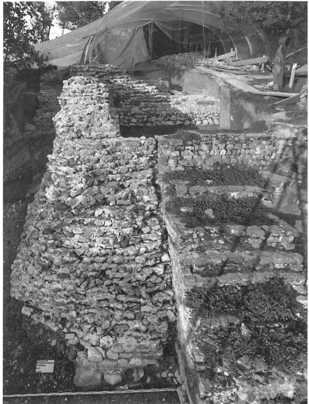
Abb. 155: Studen - Grabfeld / Petinesca 1993. Sanierung: Die am Fuss knapp 3 m mächtige Aussenmauer M5 ist freigelegt worden; im Bereich der Südost-Ecke müssen sowohl die äussere Mauerschale als auch zahlreiche Kubikmeter des Mauerkerne wieder aufgemauert werden. Blickrichtung Westen.
