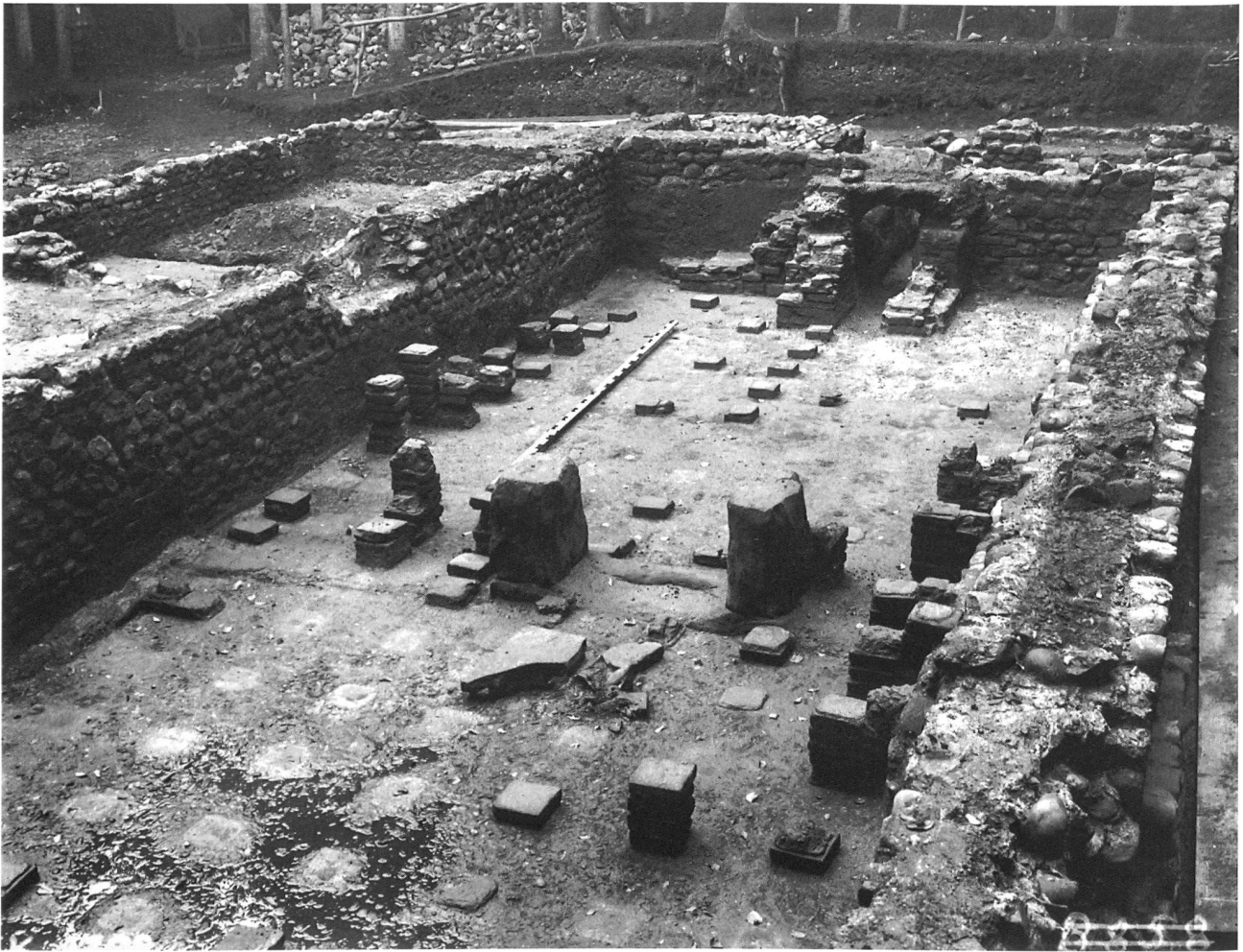
Abb. 87: Bern-Engehalbinsel - Römerbad 1937. Hypokaustanlage des Caldariums.
