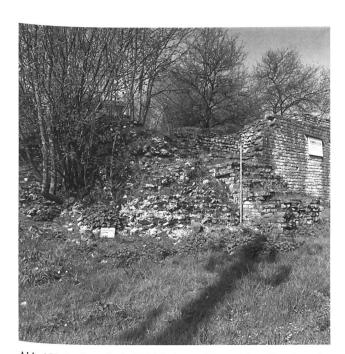
Abb. 154: Studen - Grabefeld / Petinesca. Zustand der «Toranlage» im Winter 1993. Die mächtige Aussenmauer ist vom Wurzelwerk eines Hasel- und Eschenbewuchses durchzogen und zerfällt immer mehr. Blickrichtung Nordwesten.
