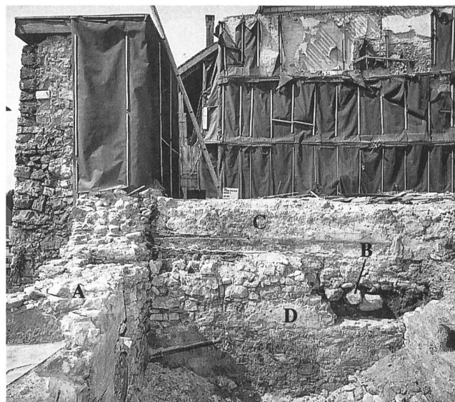
Abb. 4: Keller (9) im Innern der Stadtmauer nach Westen mit baugeschichtlichen Angaben in chronologischer Reihenfolge. A Stadtmauer, B Älteste Parzellenteilung: Steinreihe für Holzschwelle, C Brandmauer zwischen Haus 7 und Haus 9, D Keller (9).
