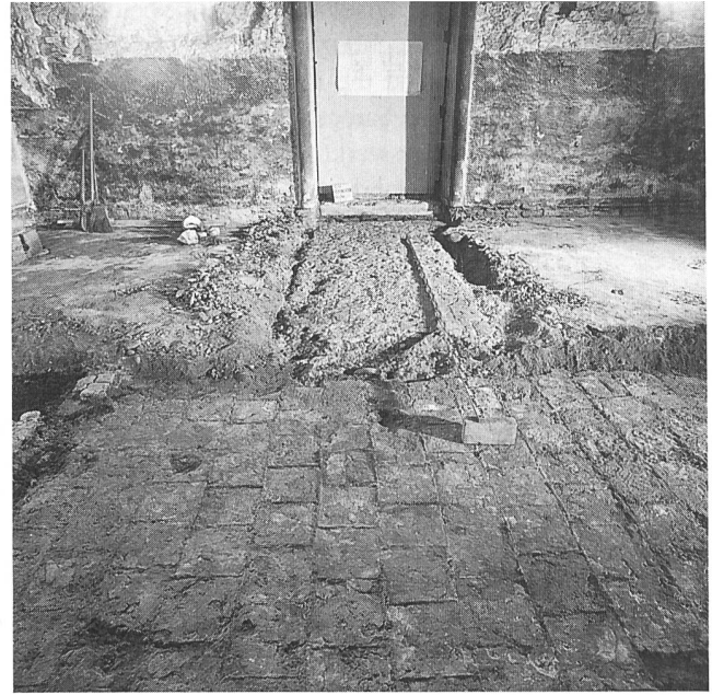
Abb. 14: Verlegemörtel des gotischen (Vordergrund) und barocken (Quer-gang) Tonplattenbodens.
