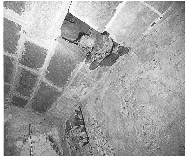
Abb. 19: Sondage im Sakristeigewölbe. Ein Fragment des originalen Deckengesimses ist sichtbar.
