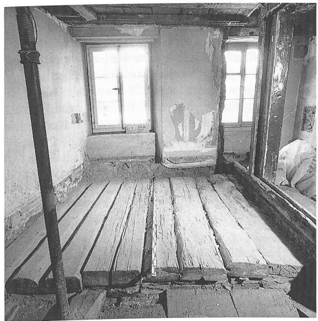
Abb. 5: Balkendeckenkonstruktion von 1409 über der Laube Bälliz 75.
