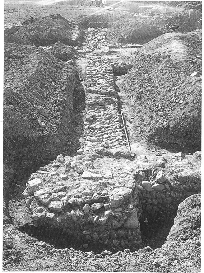
Abb. 3: Leuzigen-Kiesgrube/Thürner 1950. Fundamentreste der römischen Villa – Nordosttrakt. Im Vordergrund nordöstlicher Eckstützpfiler. Blickrichtung Süd.
