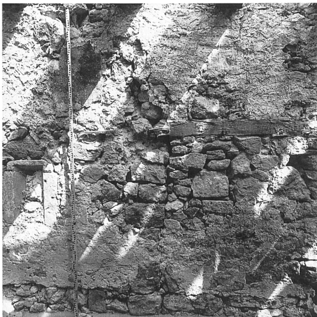
Abb. 223: Nidau, Hauptstrasse 73. Gotisches Fenster und vermauerte Türe in nördlicher Brandmauer. Aufschluss 1987.
