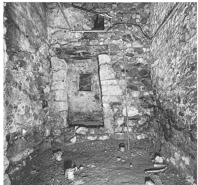
Abb. 243: Thun, Obere Hauptgasse 58. Gassenwärts zugemauertes Kellerportal mit Eichensturz im Mauerverband des Kernbaus (1230–35).
