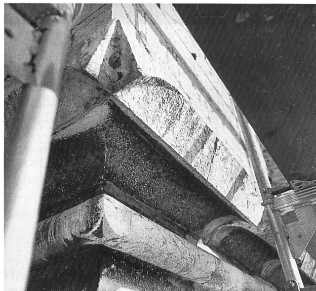
Fig. 213: La Neuveville, Tour carrée. Construction angulaire.
