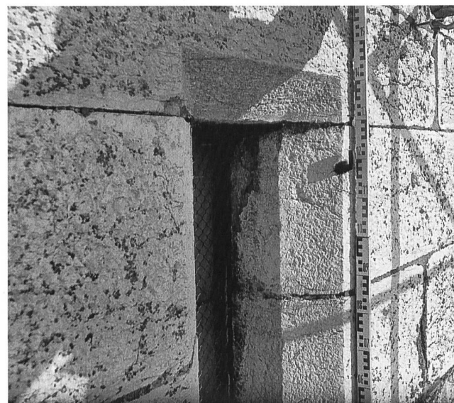
Fig. 214: La Neuveville, Tour carrée. Fenêtre rectangulaire à chanfrein avec détail de la pierre taillée.
