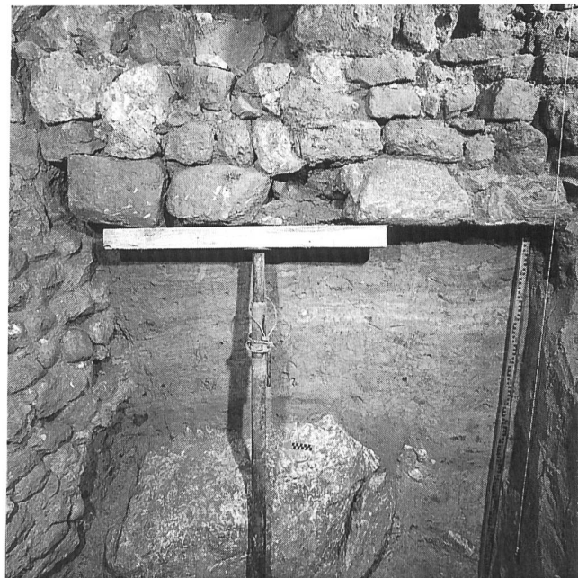
Abb. 159: Erlach, Altstadt 20. Freigelegte Fundamente: Links die Stadtmauer, oben die anstossende Brandmauer des Hauses 18.
