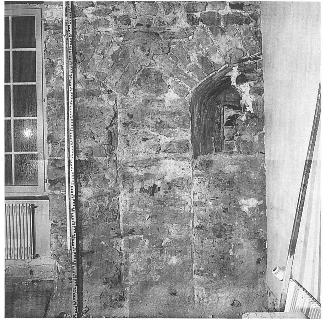
Abb. 183: Interlaken, Schloss. Fenstermbefund in der Sfidwand des ehem. Refektoriums.
