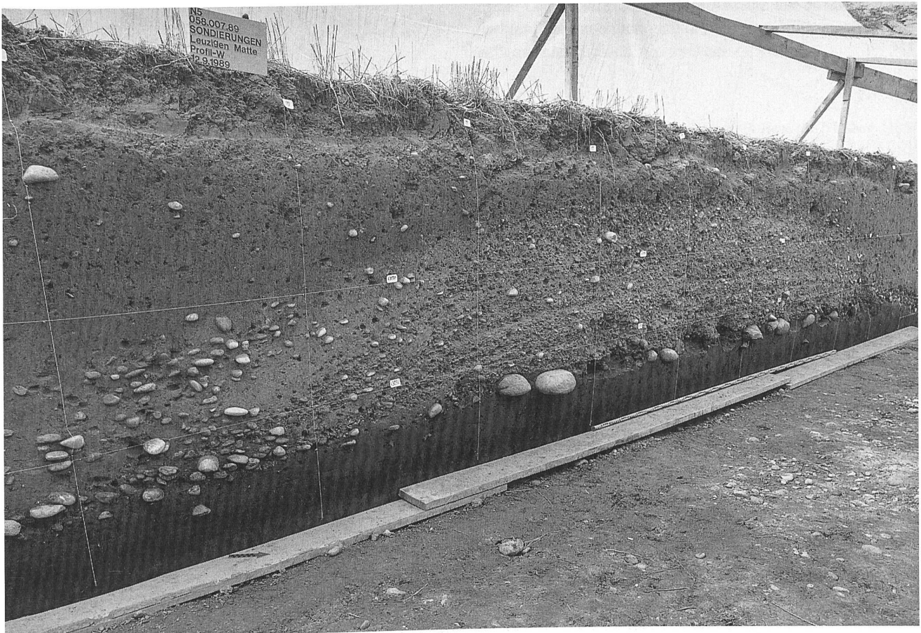
Abb. 24: Leuzigen-Matte 1989. Profilschnitt 1. Strassenkörper mit verschiedenen übereinanderliegenden Fahrbahnen. Blickrichtung Nordwest.
