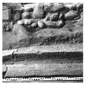
Abb.21: Sandsteingefasste Frischwasserleitung.
