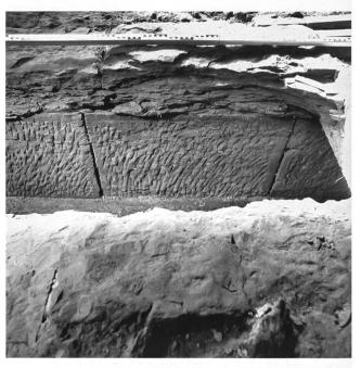
Abb.22: Sandsteingefasster Abwasserkanal.
