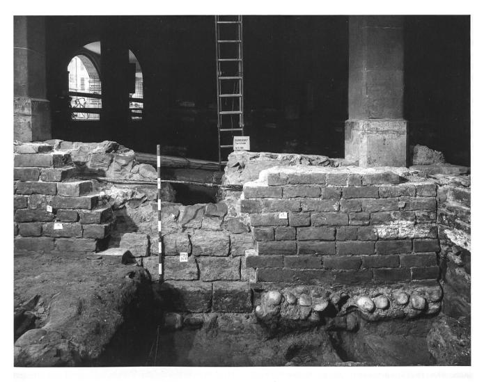
Abb.14: Die Ostmauer des Kellers von Haus II. Sandsteinquaderverband und vorgeblendete Backsteinmauerung.
