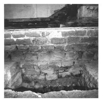
Abb.10: Sandsteinquaderwerk auf Kieselbollenlage der Westmauer von Haus I. Blick nach Westen.
