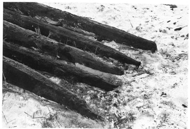
Abb. 2: Aegerten – Schwadernaustrasse 1972. Spitzen der ausgezogenen Eichenpfähle.
