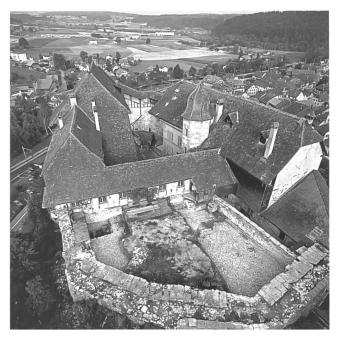
Abb.103: Laupen, Schloss. Die Gesamtaufnahme von Osten zeigt die elliptische Grundform der von dicken Ringmauern geschützen Hauptburg. Im Vordergrund die Ostbastion während der Grabung 1983.
