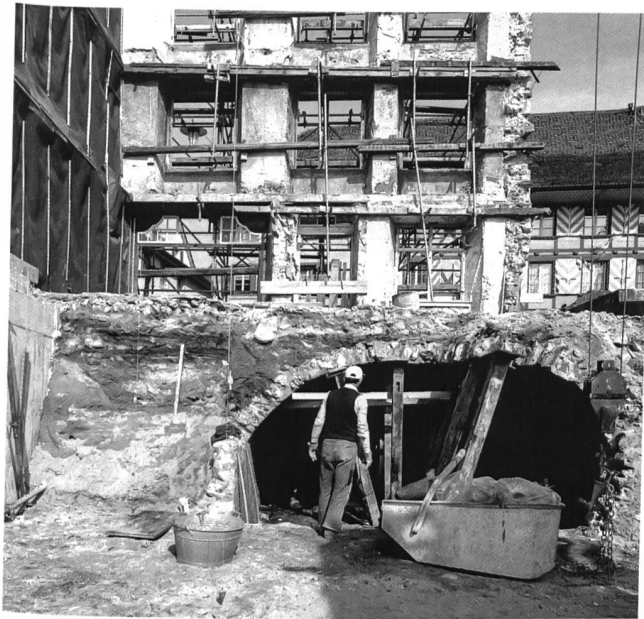
Abb. 135: Wiedlisbach, Städtli 9. Im Erdprofil links sind deutlich die von der Kellergrube durchschlagenen Schichten als schwarze Streifen erkennbar.
