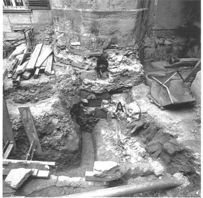
Abb.104: Laupen, Schloss. Der Treppenturm des «Neuen Schlosses» gründet im Burggraben der Kernburg. A Wehrmauer am östlichen Grabenrand.
