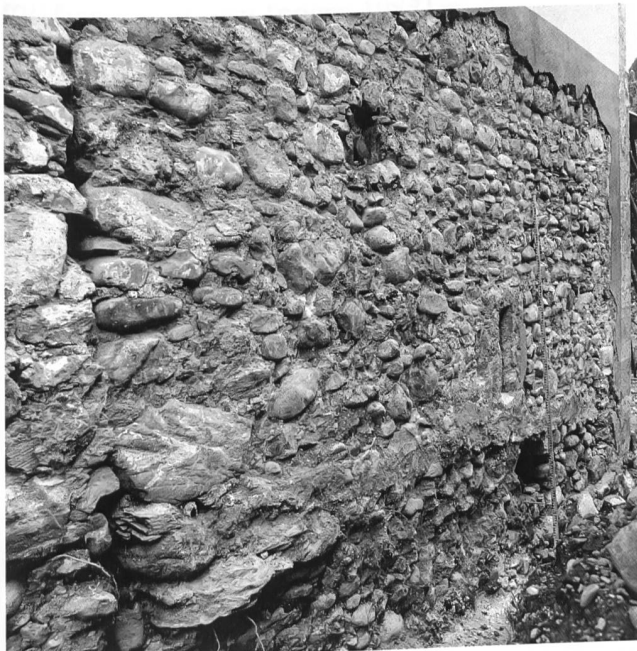
Abb.123: Saanen, Pfarrhaus. Ansicht der Westfassade nach Süden mit Baunaht des Kernbaus.
