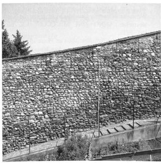
Abb.124: Thun, Hohle Messe/Schloss. Ansicht von Westen an die Stadtmauer vor der Sanierung mit Angabe der Zinnen (punktierte Linie).
