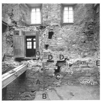
Abb.105: Laupen, Schloss. Südliche Wehrmauer (A) nach Abbruch der ehemaligen Pfisterei. Blick nach Süden in den einstigen Binnengraben (B). Im Sandsteinmauerwerk ist ein Fensterschlitz (C) erkennbar, darüber neuere Einbauten von Backöfen (D), rechts der Anstoss des Palas (E).
