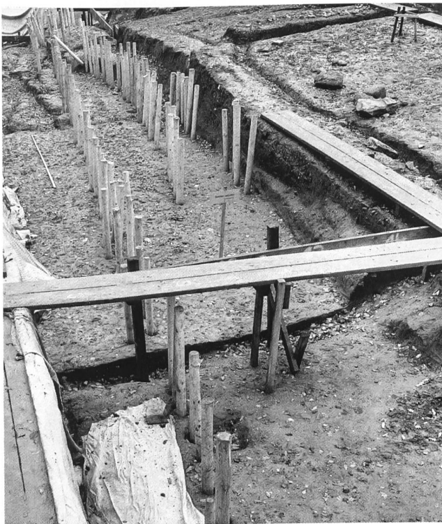
Abb. 50: Studen-Vorderberg 1988. Rekonstruktion der Hangverbauung. Die in die erhaltenen Pfostenlöcher eingesteckten Rundhölzer zeigen die vertikalen Elemente der Hangverbauung, die zur Festigung der Terrenaufschüttungen dienen.
