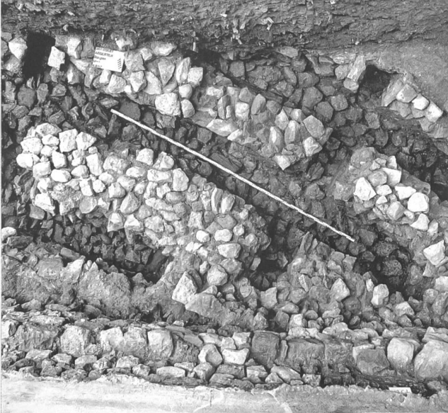
Abb. 28: Aegerten-Bürglen 1987. Fundamentbereich des nördlichen Halbrundturmes der spätrömischen Anlage. Die Negative (Balkengräben) der drei mauerparallelen Balken sind klar erkennbar. Die in Abständen von 2–3 m verlegten Querbalken verbinden die mauerparallelen Balken zu einem effektiven Holzrost und sorgen für den nötigen Halt des über einem Pfahlfeld (vgl. Aegerten–Isel, Abb. 27) errichteten Fundamentes.
