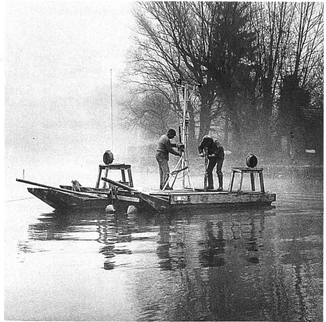
Abb. 6: Bielerseeprojekt 1984–87. Ipsach. Kernbohrung ab schwimmender Plattform.
