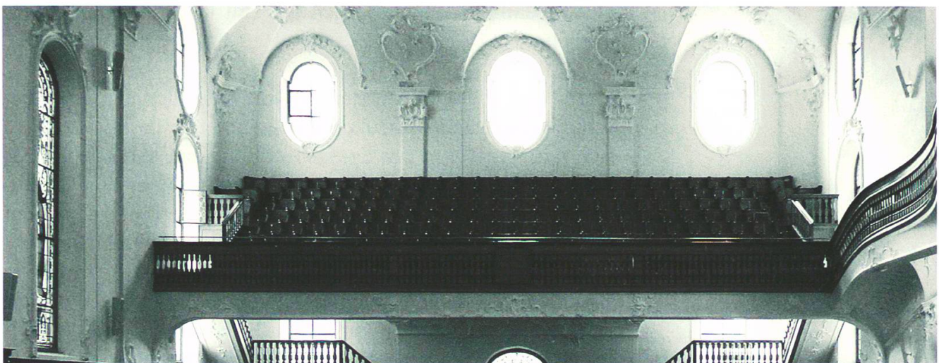
Abb. 12: Freitragende Emporen in der Kirche Wädenswil (1767).
