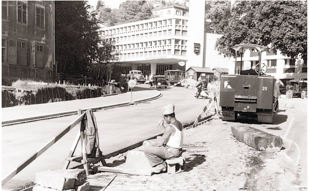
Strassenbauarbeiten der Firma Cellere AG, die 1919–1921 den Landsgemeindeplatz Trogen neu pflästerte. Ein Arbeiter bearbeitet einen Randstein. Unterer Graben, St. Gallen, Sommer 1956.
