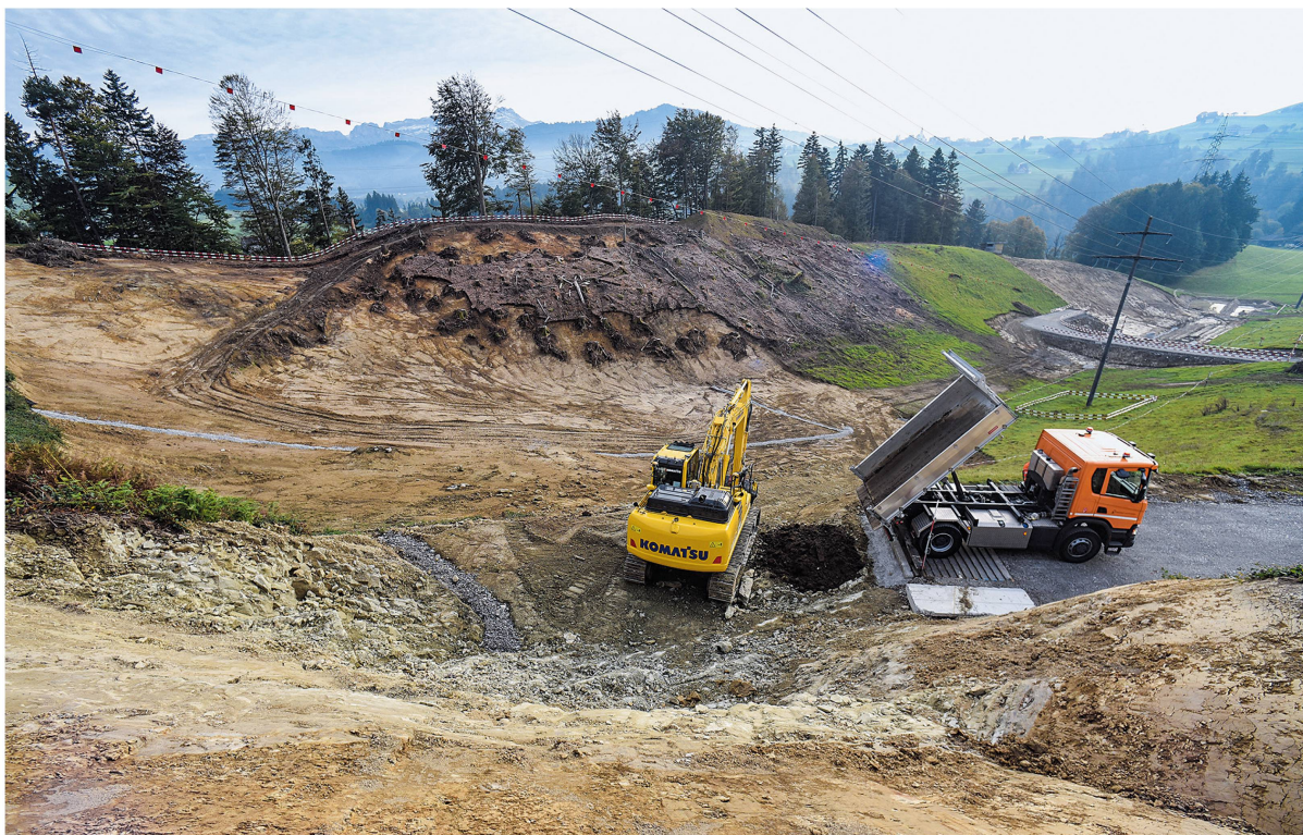
In Teufen entstand eine vom Ausserrhoder Tiefbauamt betriebene Deponie für Inertstoffe.
