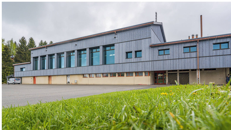
Die sanierte Schwellbrunner Mehrzweckanlage wurde nach einem Jahr Bauzeit im Frühling wieder in Betrieb genommen. Die Kosten der Instandstellung beliefen sich auf 7,3 Mio. Franken.
