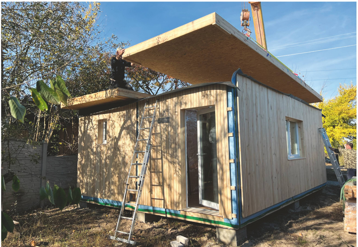
Endmontage eines Wohnmoduls.
