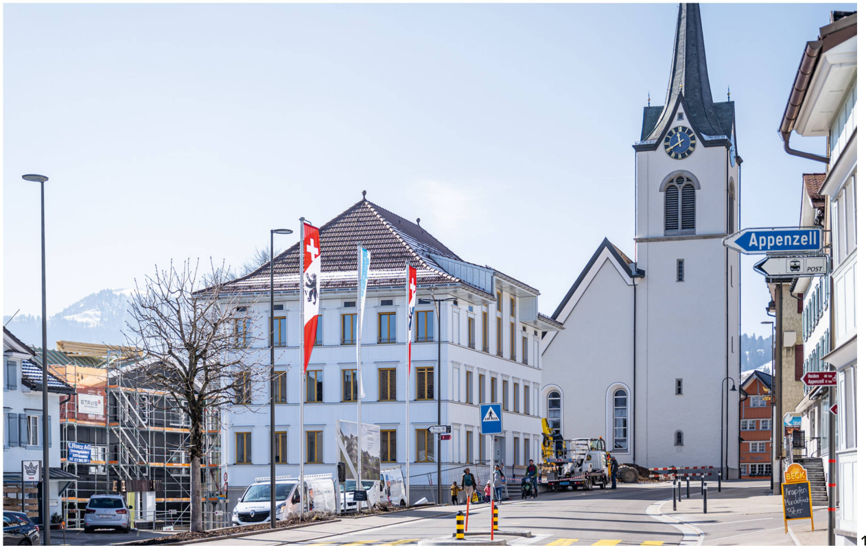
Die neue Gemeindekanzlei.
