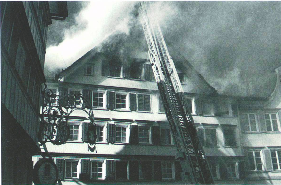
Am 29. September wurden an der Gossauerstrasse vier Wohn- und Geschäftshäuser durch einen Brand weitgehend zerstört.
