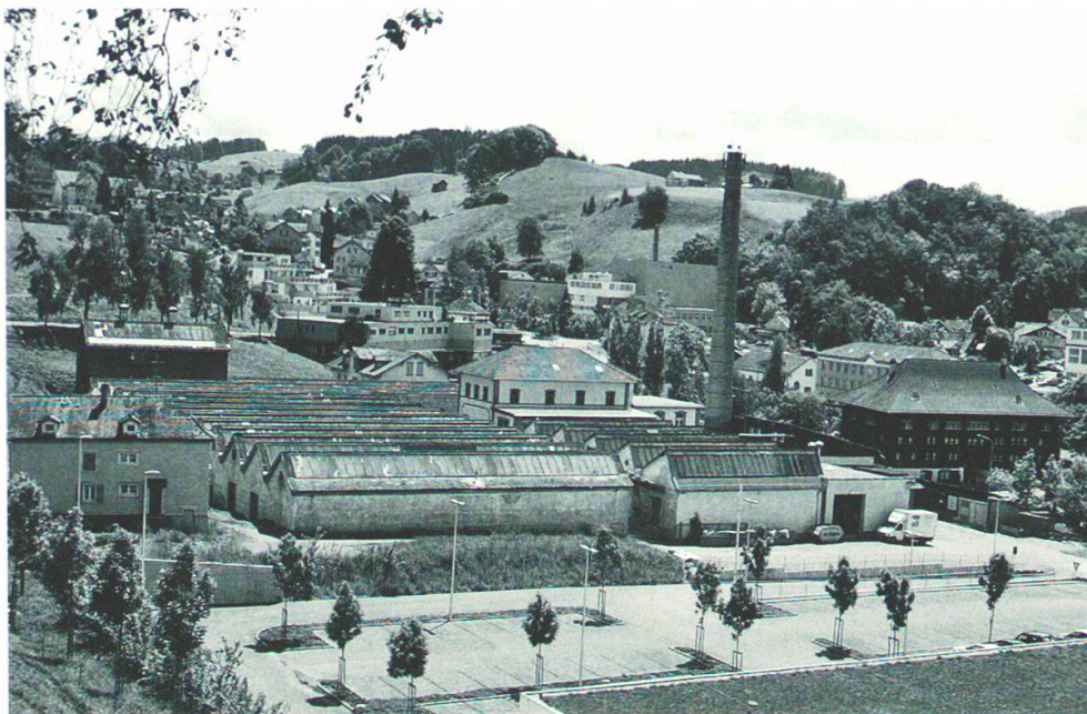
Das ehemalige Werk 3 der AG Cilander wurde abgebrochen.
