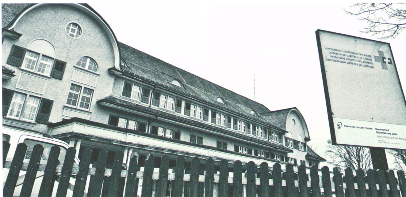
Der Kantonsrat stimmte Krediten für die Umnutzung des Zeughauses in Herisau für die kantonale Verwaltung zu.
