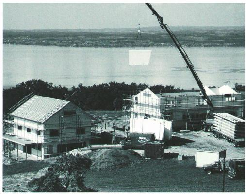
Einfamilienhaus, Hueb, Wolfhalden, 2009. Projektierung und Ausführung: Nägeli AG, Holz- und Innenausbau Gais. Für die Konstruktion wurden gut 200m³ Holz verbaut, 98m³ AppenzellerHolZ für Aussen- und Trennwände, 99m³ Brettstapel für Zwischenboden und Dach und 5m³ Brettschichtholz. Das Holz stammt aus den Wäldern vom Hirschberg und Gäbris. Das Haus besteht aus 90 Elementen (Wände, Zwischenwände, Böden und Dach).
