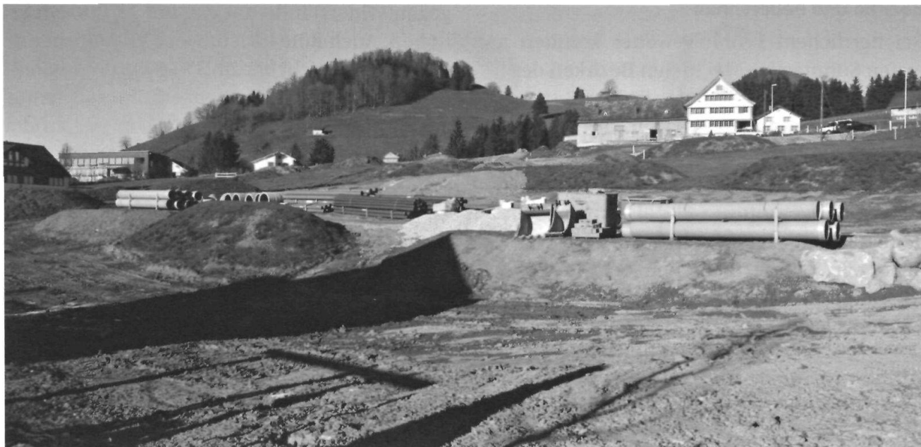
Überbauung der Liegenschaft Schönenbüel-Lehn.
