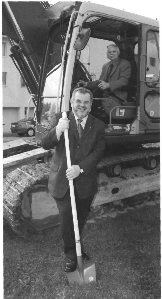
Die Regierungsmitglieder Hans Diem (vorne) und Jakob Brunnschweiler beim Spatenstich für das Untersuchungsgefängnis in Gmünden. (Bild: Archiv Appenzeller Zeitung)
