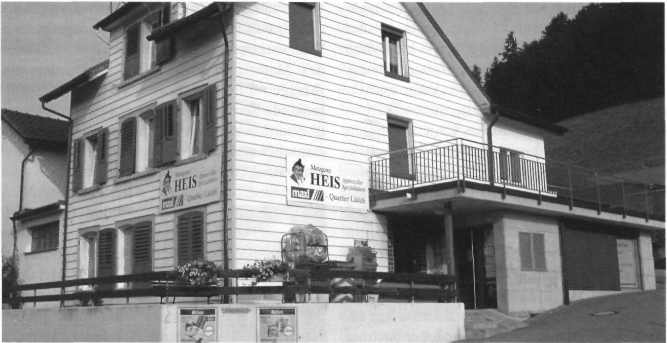
Der Quartierladen samt Metzgerei besteht dank Herbert Heis weiter.
