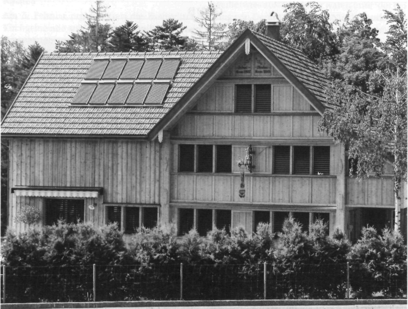
Der ehemalige «Schweizerbund» wurde als 13. Gebäude vom Kanton minergie zertifiziert. (Bild: Isabelle Kürsteiner)
