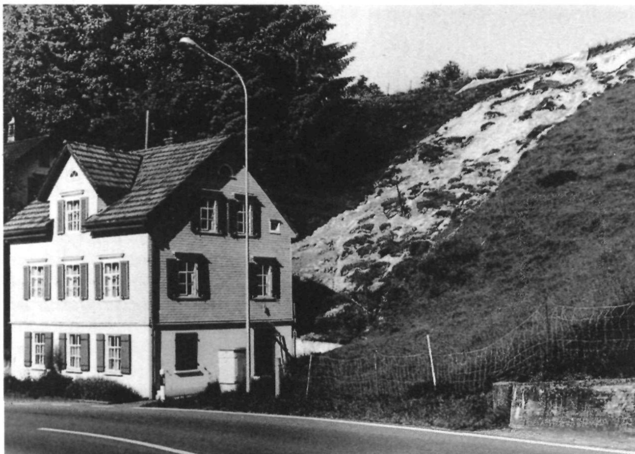
Heftige und anhaltende Regenfälle ab dem 11. Mai 1999 führten im Gehr zu einem gewaltigen Schlipf, der ein Haus an der Durchgangsstrasse Schachen–Reute Dorf beschädigte.
