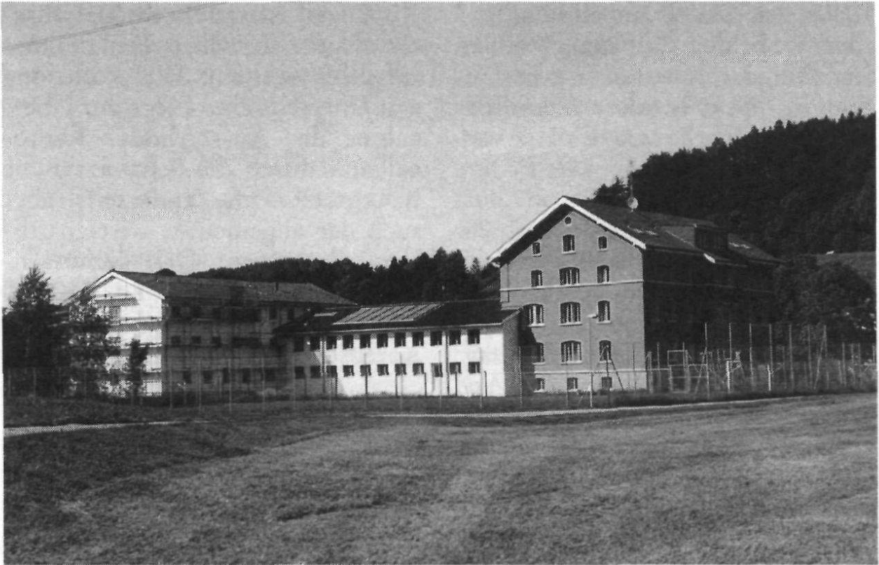
Die umfassende bauliche Sanierung der Strafanstalt Gmünd ist abgeschlossen worden.
