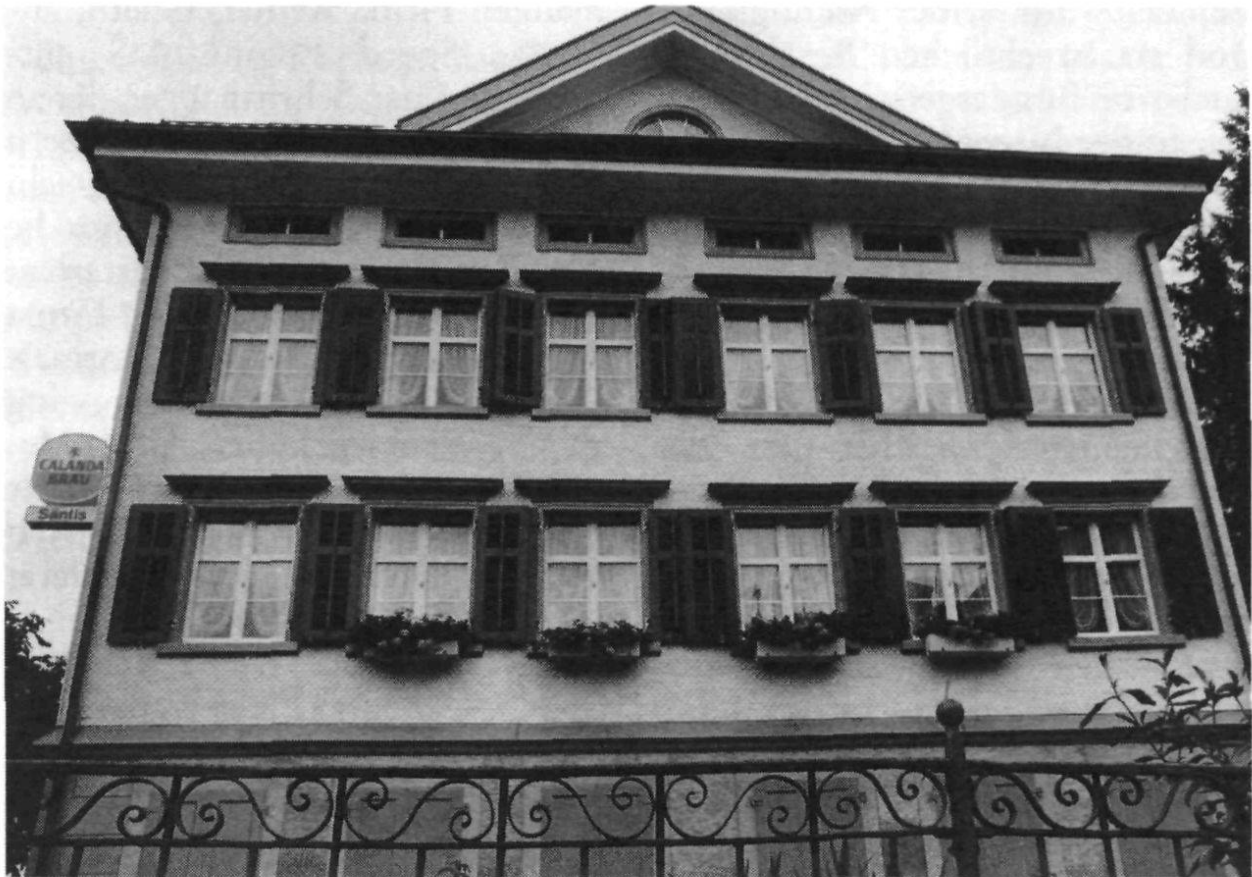
Im Ortsteil Lachen wurde das klassizistische, 140 Jahre alte Gebäude Restaurant Säntis einer stilgerechten Renovation unterzogen.
