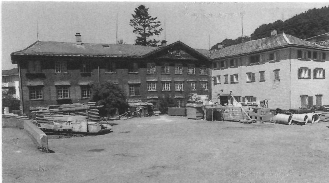
Zwei einstige Appreturgebäude gleichen Alters im Winkel zueinanderstehend – die Gegensätze und die Wohnlichkeit des Vorhofes sprechen für sich.
