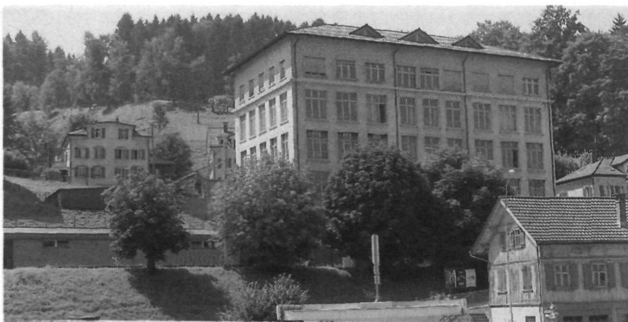
Das Geschäftshaus der zweiten Generation Buff, schon als Neubau mit Lift ausgestattet, überragt das Bahnareal Wilen.
