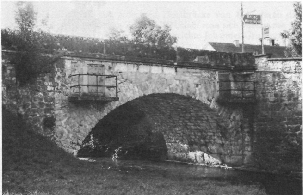
Ostansicht der Strassenbrücke in Tegerfelden, heutiger Zustand.
