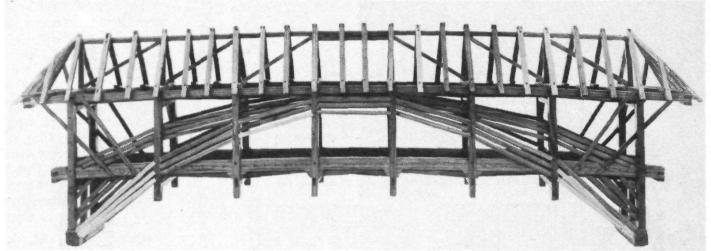
Abb. 16 (oben). Originales Brückenmodell, Mitte 18. Jahrhundert, von Hans Ulrich Grubenmann (Zuschreibung), mit einem Spreng- und Hängewerk. Gemeinde Stein.
