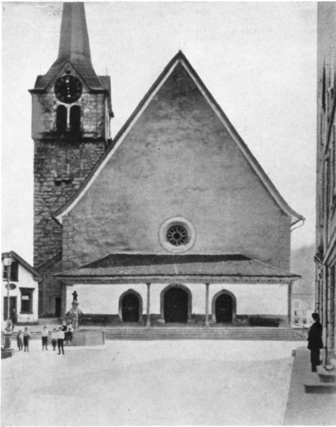
Herisau, die Westfassade vor der neugotischen Renovation von 1906 mit den korbboigigen Portalen von 1782, dem Vorzeichen von 1790 und dem spätgotischen Rundfenster (Foto unbekannter Herkunft).
