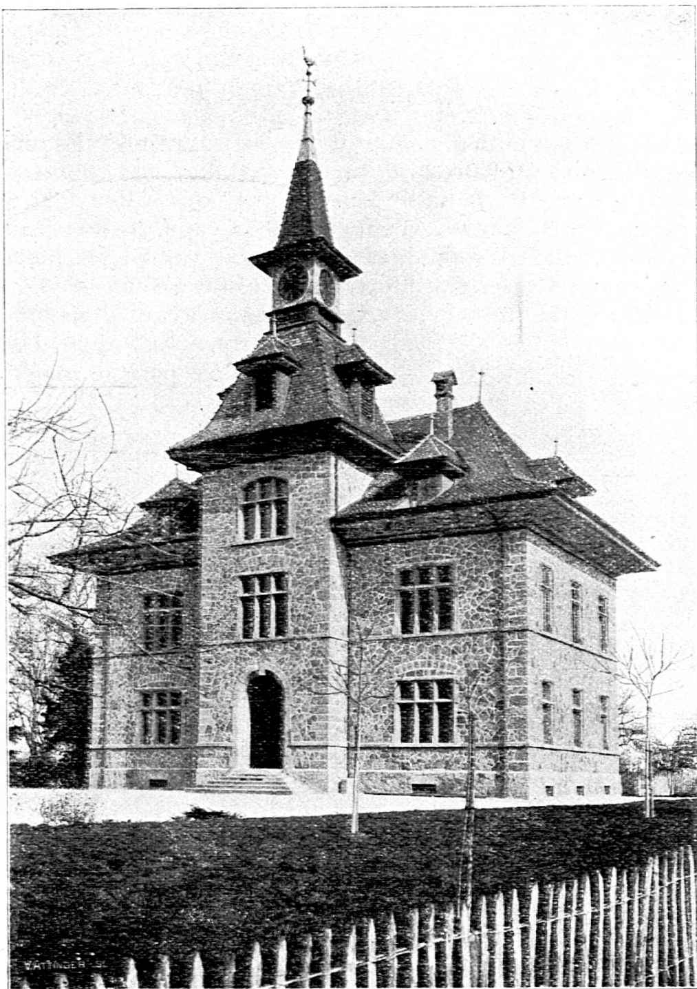
La maison d'école de Marin (construite en 1900).
