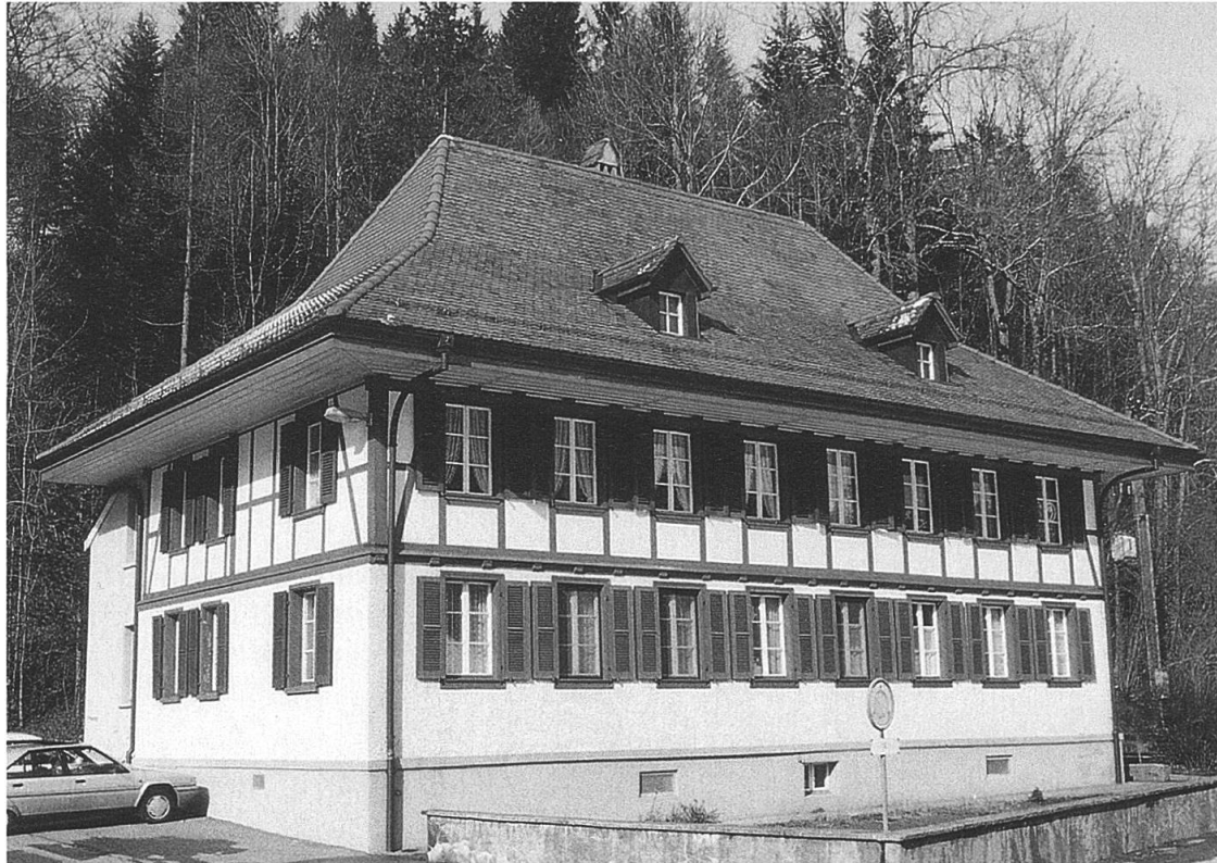
Abb. 132: Ansicht von Süden, Strassenfassade. Aufnahme 2000. (E.S.).
