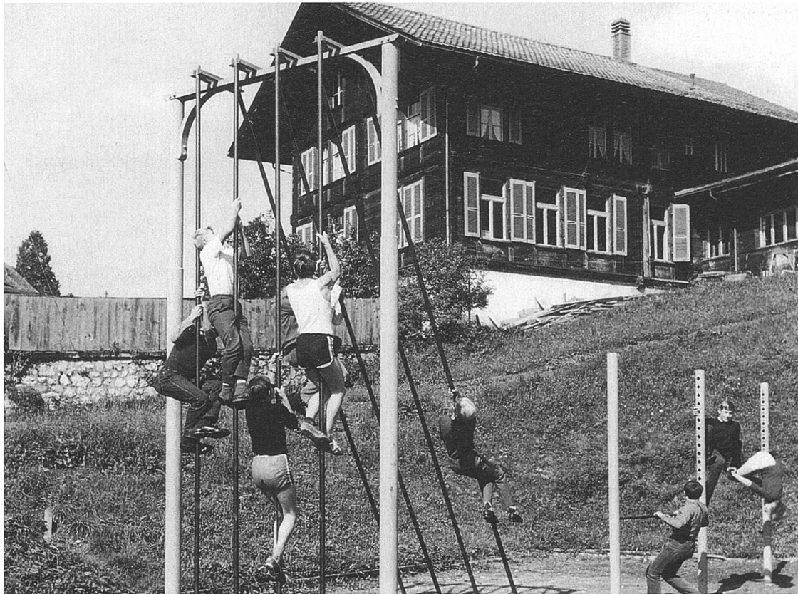
Abb. 96: Turnplatz und Ansicht des Schulhauses von Südosten. Im Erdgeschoss befinden sich die Schulzimmer, im Obergeschoss die Wohnung. Aufnahme um 1968. (Maurer AG, Spiez. Alfred Lory, Erlenbach).
