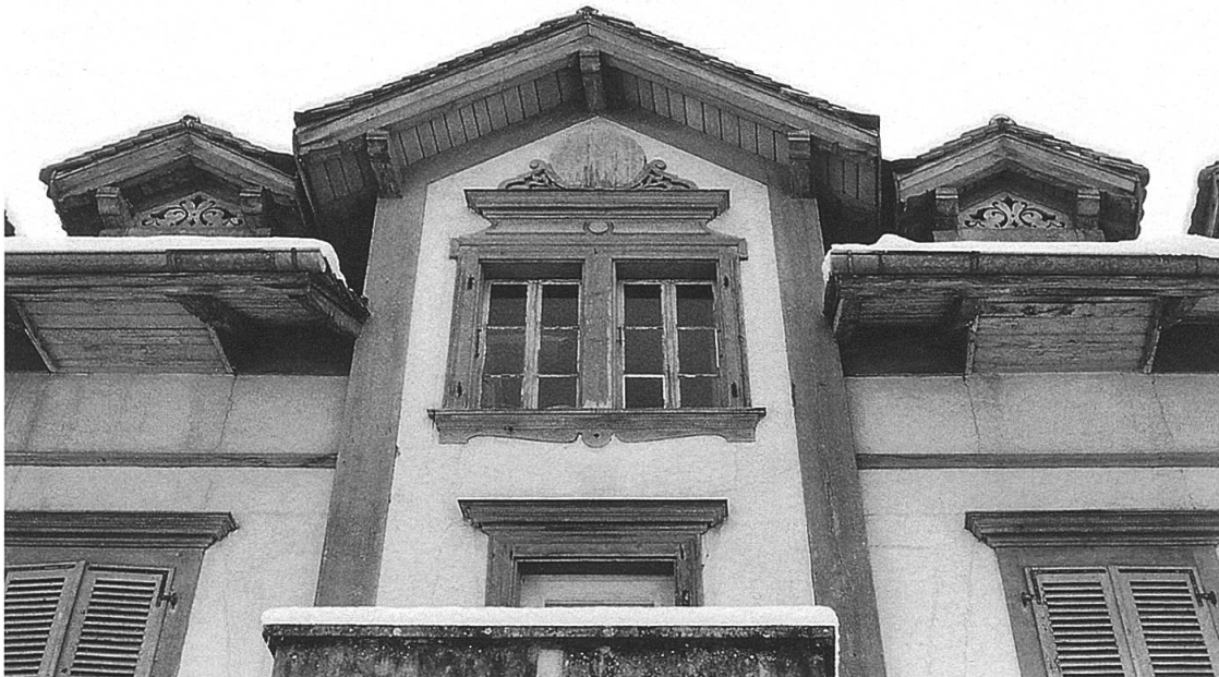
Abb. 138: Mittelrisalit der Hauptfassade und Dachpartie, Aufnahme 2000. Die Verdachung des Doppelfensters dient gleichzeitig als Sockel für die ursprünglich geplante Uhr. (E.S.).
