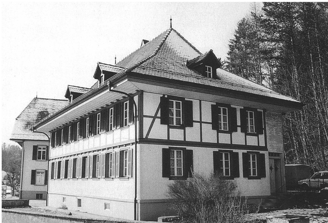
Abb. 133: Ansicht von Osten, Aufnahme 2000. Das Walmdach stammt wohl aus der Zeit nach dem Brand von 1912. (E.S.).
