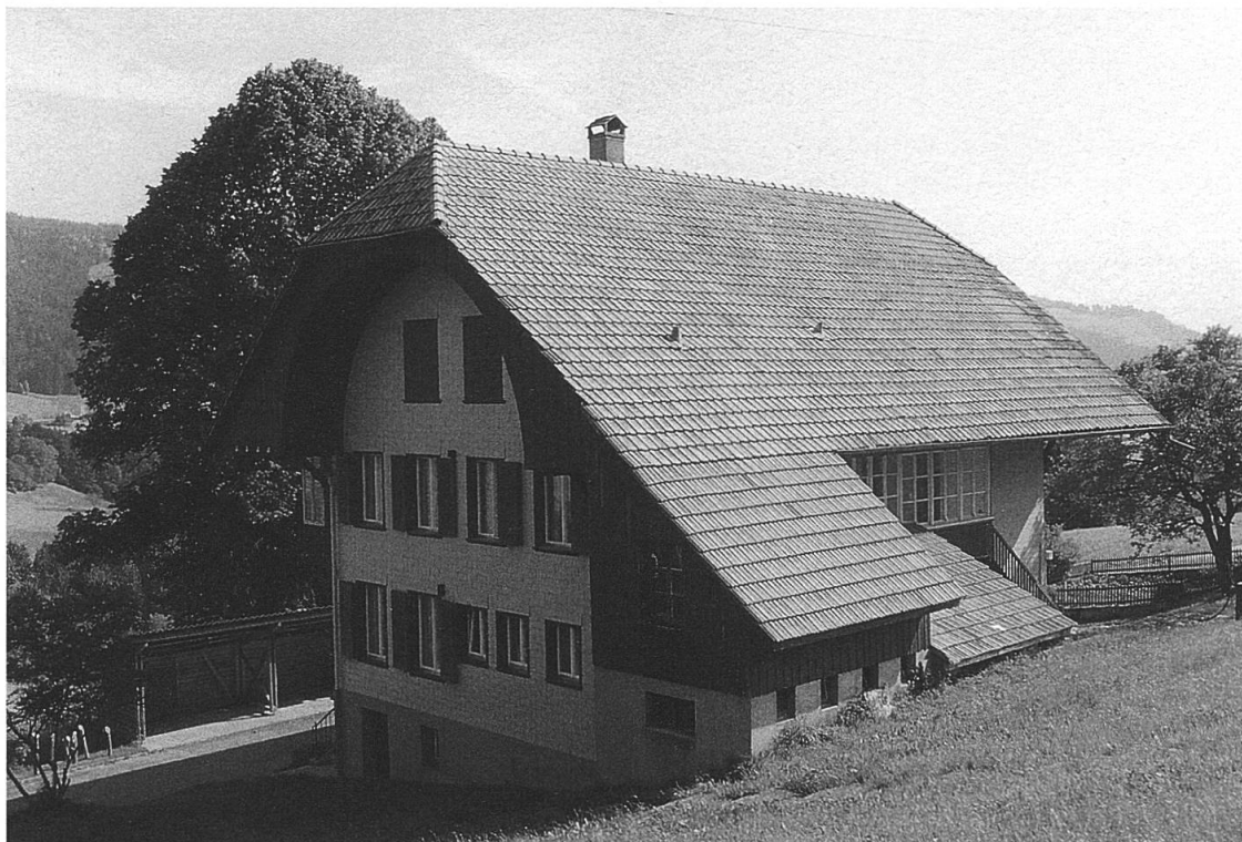
Abb. 109: Ansicht von Norden, Aufnahme 1999. In der Bildmitte der ehemalige Toilettenanbau. Im daran angrenzenden Teil des Schulhauses befand sich früher ein Stall. (E.S.).
