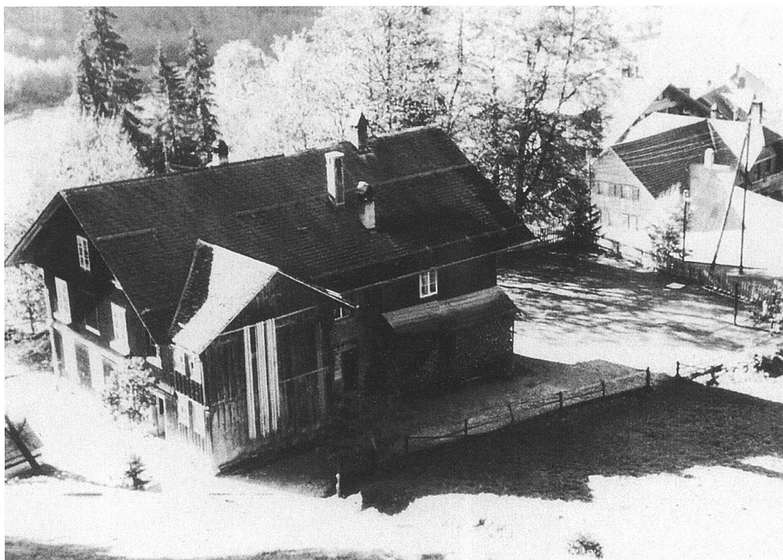
Abb. 101: Aufnahme Mitte 20. Jahrhundert. Links im Bild der Toilettenanbau. (Repro Christoph Wüthrich, Rüscheegg-Gambach).
