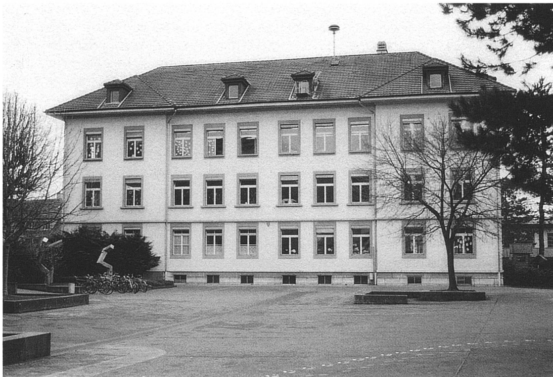
Abb. 111: Südostfassade, Aufnahme 2001. Der Fassadendekor ist gegenüber dem ursprünglichen Zustand stark vereinfacht. (KDP, Stephan Steger).
