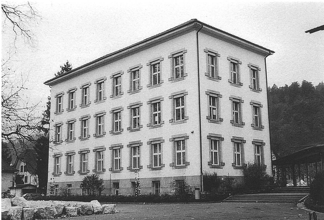
Abb. 107: Ansicht von Osten, Aufnahme 2001. (KDP, Karin Zaugg).
