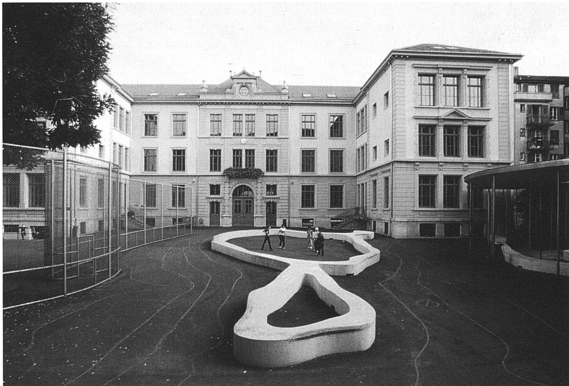
Abb. 71: Nordfassade und Pausenhof, nach der Restaurierung. Aufnahme 1999. (AAT Creation Sàrl, Grandcour).
