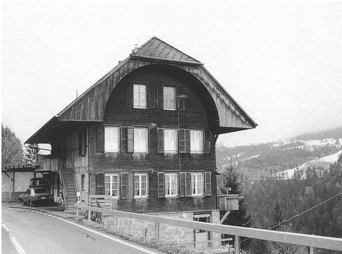
Abb. 95: Ansicht von Westen, Aufnahme 2000. Die Hauptfassade des Riegbaus ist mit Holzschindeln verschalt. (E.S.).
