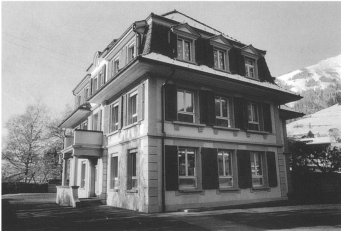
Abb. 99: Ansicht von Süden mit dem Mansarddach von 1926. Aufnahme 1995. (KDP, Hansruedi Marti).
