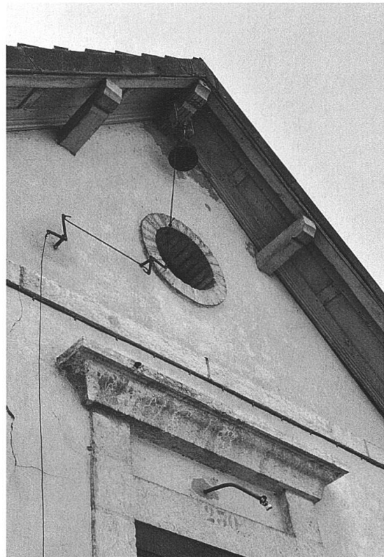
Abb. 84: Detail der Eingangspartie, Aufnahme 2000. Unter dem Vordach hängt die Schulglocke. (E.S.).
