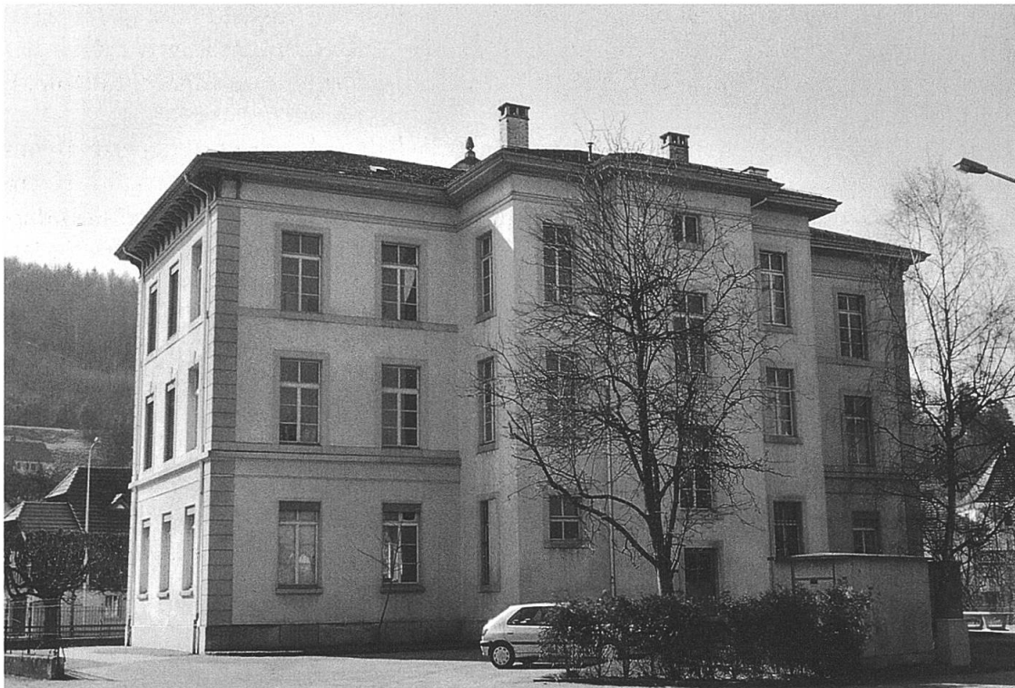
Abb. 144: Ansicht von Nordosten, Aufnahme 2000. Erschliessungsseite mit dem Toiletten- und Treppenhausvorbau. (E.S.).
