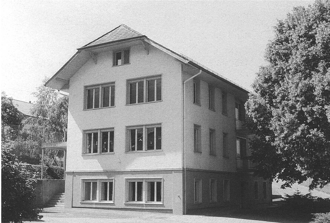
Abb. 141: Ansicht von Südosten, Aufnahme 1999. Die breiten Fensteröffnungen gehen auf den Umbau von 1963/64 zurück. (E.S.).
