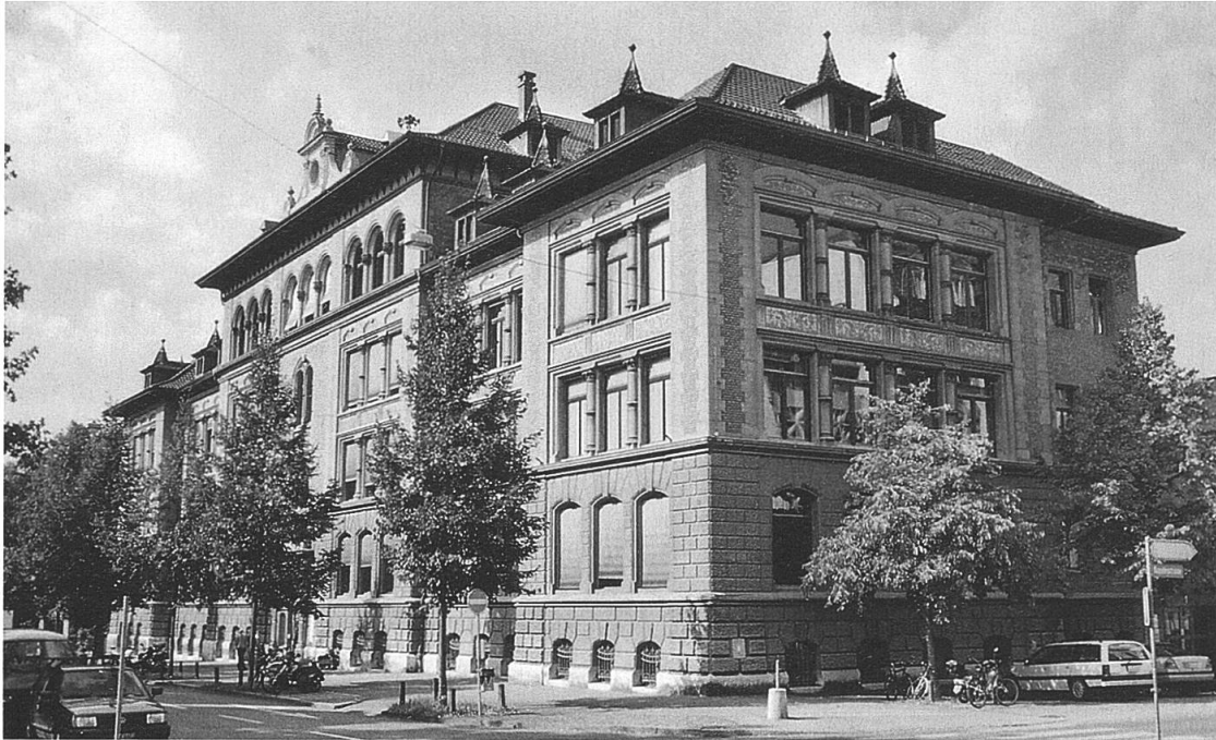
Abb. 53: Hauptfassade. Ansicht von Nordosten, Aufnahme 1999. (E.S.).
