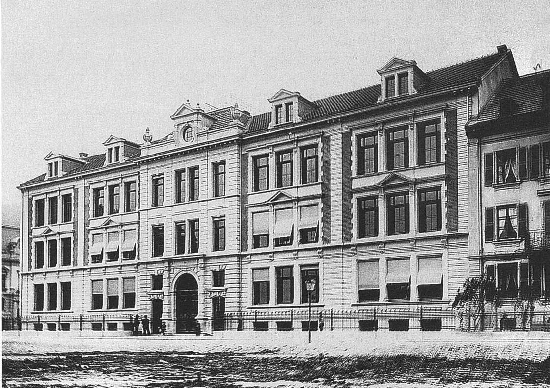
Abb. 70: Südfassade, Aufnahme um 1900. (Stadt Biel, Abteilung Hochbau).
