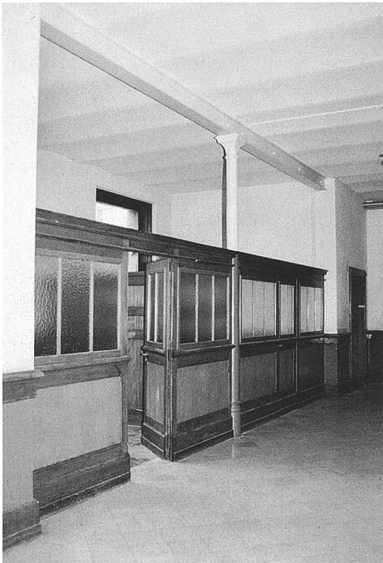
Abb. 59: Garderobennische mit hölzernen Trennwänden, Aufnahme 2000. (E.S.).
