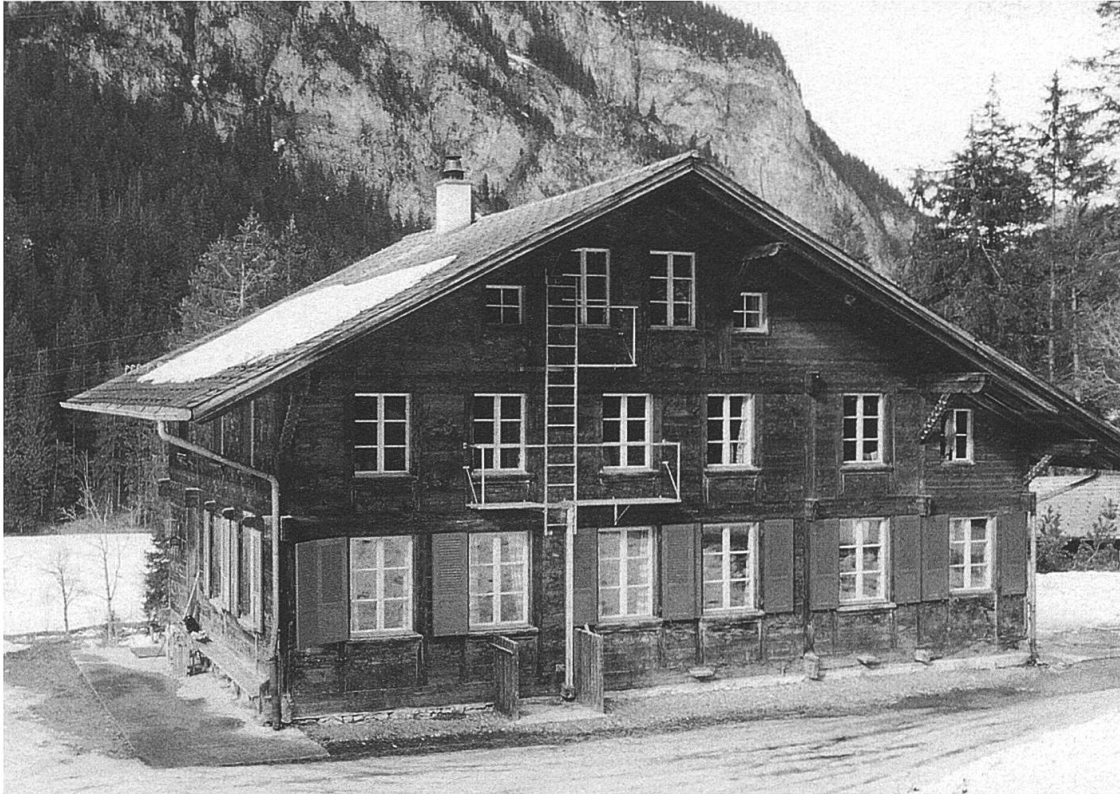
Abb. 88: Hauptfassade, Aufnahme 2000. Im Obergeschoss die Wohnräume, im Erdgeschoss das ehemalige Schulzimmer mit grösseren Fenstern. (E.S.).
