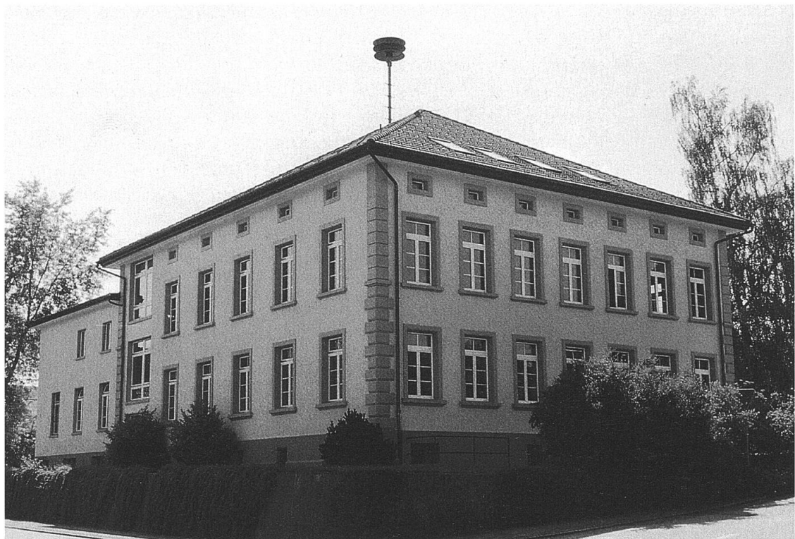
Abb. 75: Ansicht von Nordwesten, Aufnahme 1999. Links im Bild der Anbau von 1963. (E.S.).
