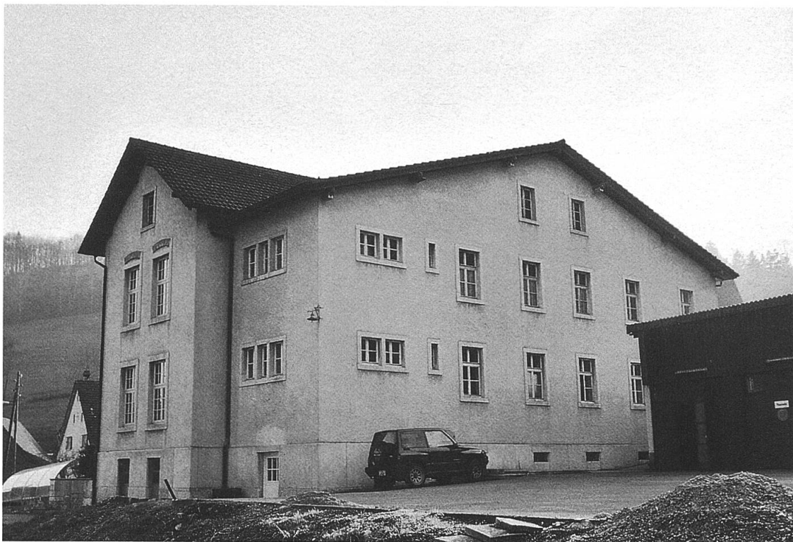
Abb. 91: Nordtrakt mit den Wohnräumen. Ansicht von Nordosten, Aufnahme 2000. (E.S.).
