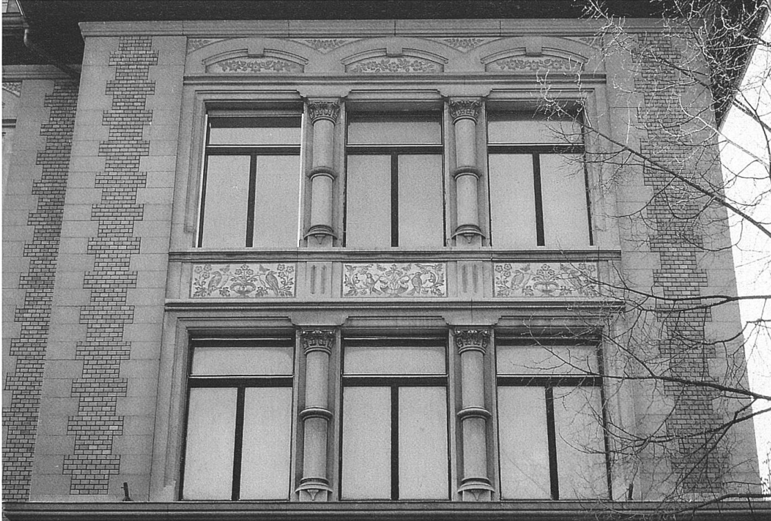
Abb. 55: Hauptfassade, Stirnseite des ehemaligen Zeichen- und des Gesangssaales im ersten und zweiten Obergeschoss, Aufnahme 2005. Die Fenstergliederungen bestehen aus ockerfarbigem Kalkstein, die seitlichen Fassadenflächen sind mit Backstein verkleidet und mit Sandstein eingefasst. (E.S.).
