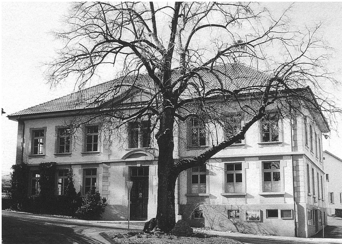
Abb. 122: Aufnahme 2000. Der Fassadendekor ist vereinfacht. (E.S.).
