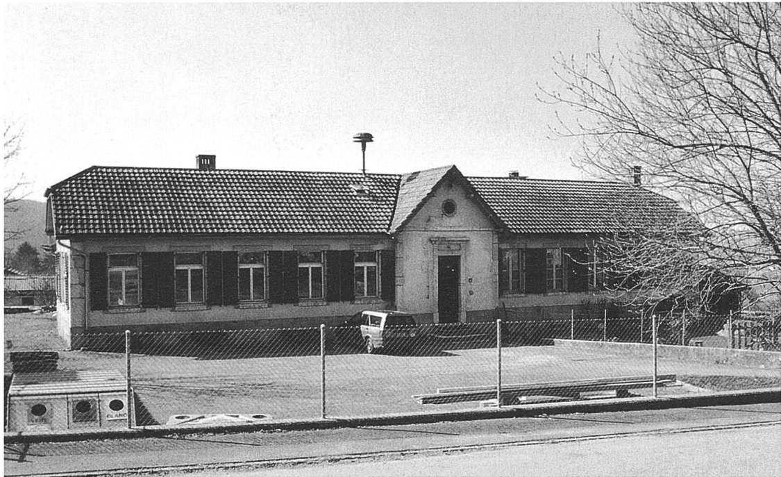
Abb. 82: Ansicht von Osten, Aufnahme 2000. Links im Bild das Schulzimmer, rechts die Wohnung. (E.S.).
