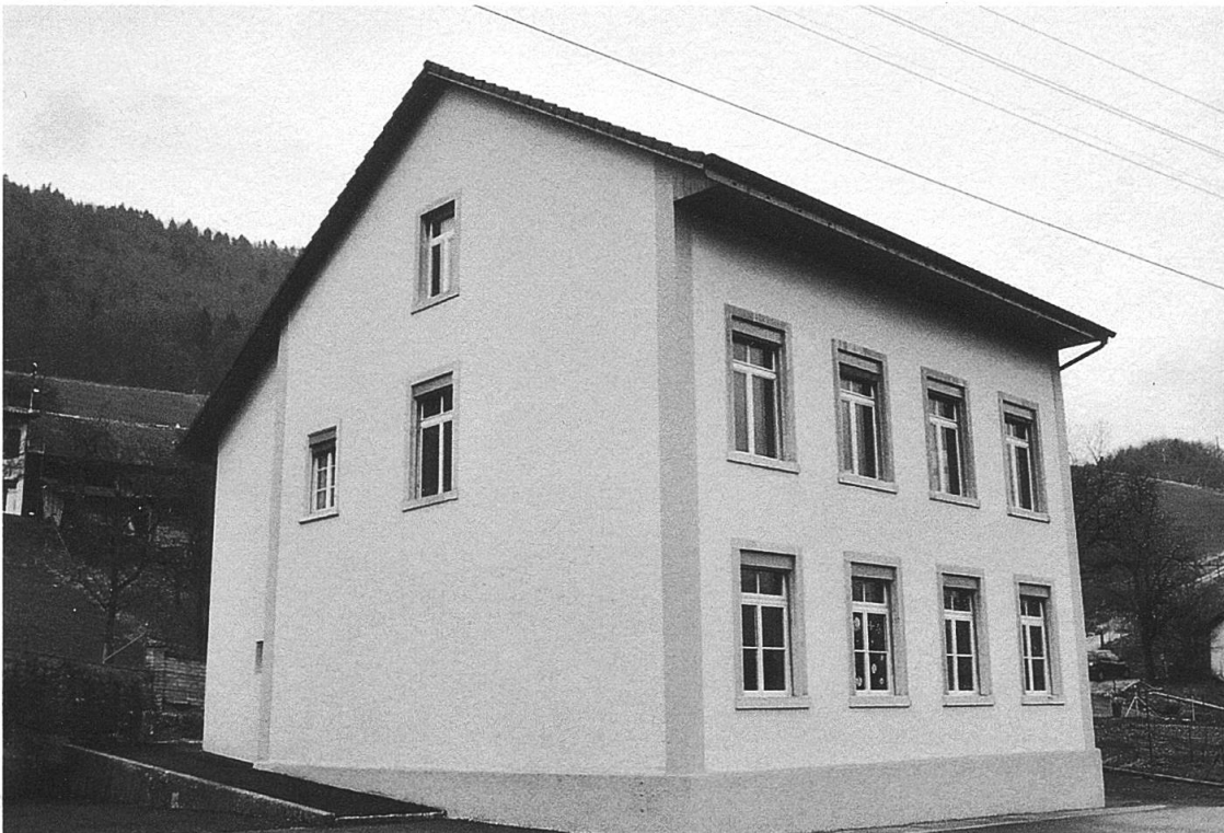
Abb. 127: Ansicht von Süden, Aufnahme 2000. Links im Bild ein jüngerer Anbau. (E.S.).
