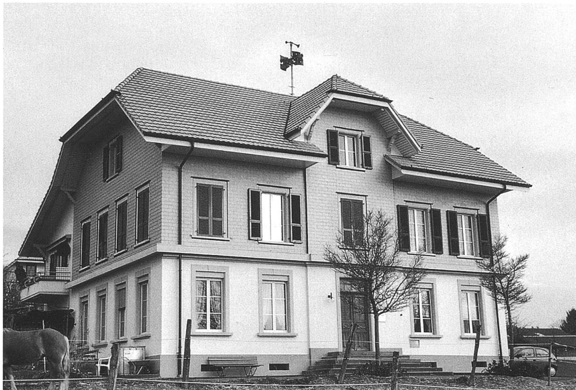
Abb. 118: Ansicht von Süden, mit Gehrschilddach von 1977. Aufnahme 2000. (E.S.).
