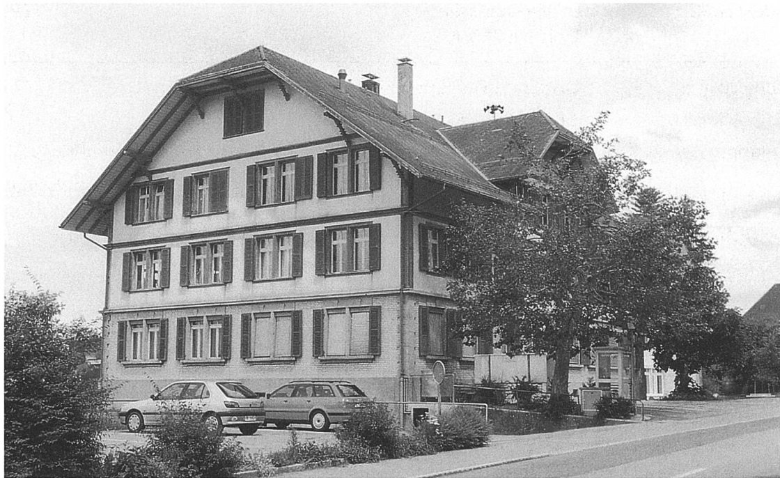
Abb. 130: Ansicht von Westen, Aufnahme 1999. Erdgeschoss in Massivbauweise, Obergeschosse verputzte Fachwerkkonstruktion. (E.S.).
