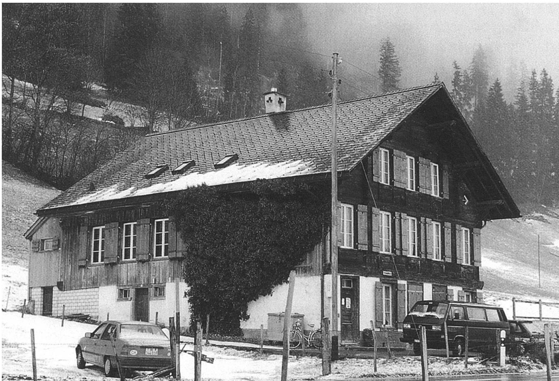
Abb. 135: Ansicht von Westen, Aufnahme 2000. Über dem Haupteingang liegt das ehemalige Arbeitszimmer. (E.S.).
