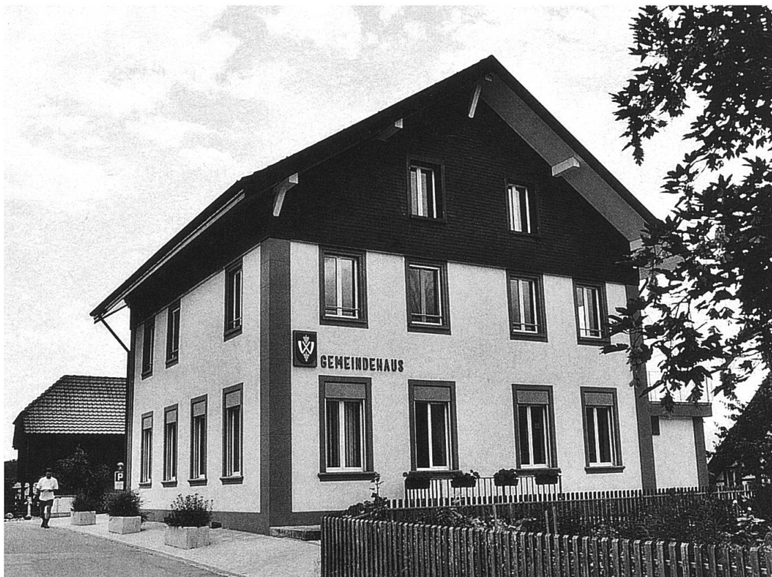
Abb. 148: Ansicht von Osten, Zustand nach dem Umbau von 1997. Aufnahme 1999. (E.S.).
