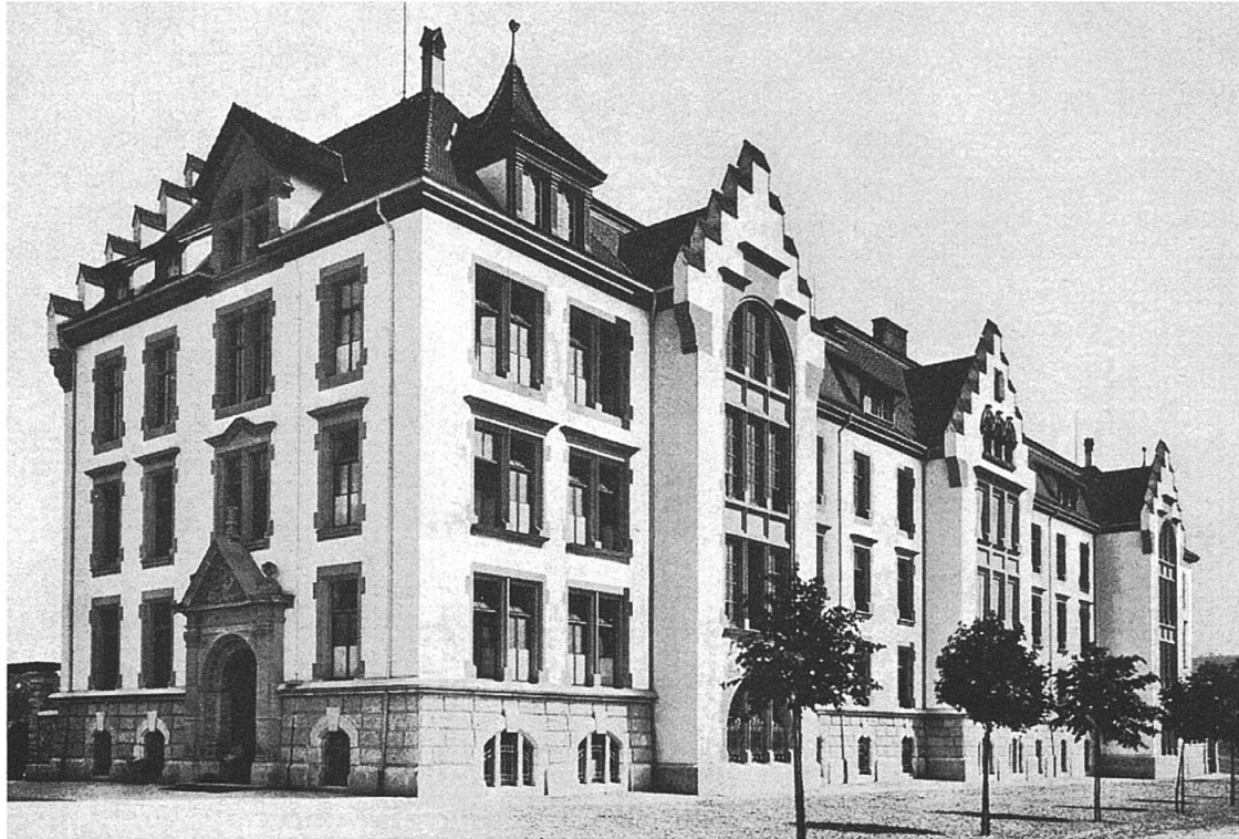
Abb. 63: Ansicht von Norden, um 1907. Erschliessungsseite längs der Gotthelfstrasse mit den beiden Treppenhäusern, links im Bild der Haupteingang an der Schmalseite. (Aus: Baudin 1907, bei 426).
