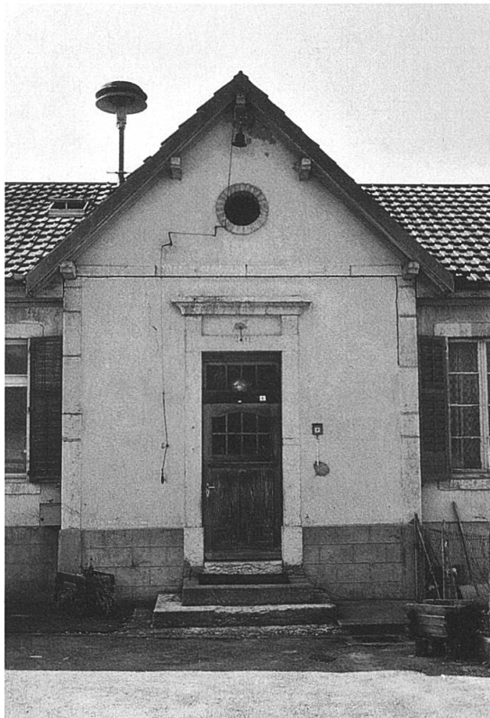
Abb. 83: Eingangspartie, Aufnahme 2000. (E.S.).
