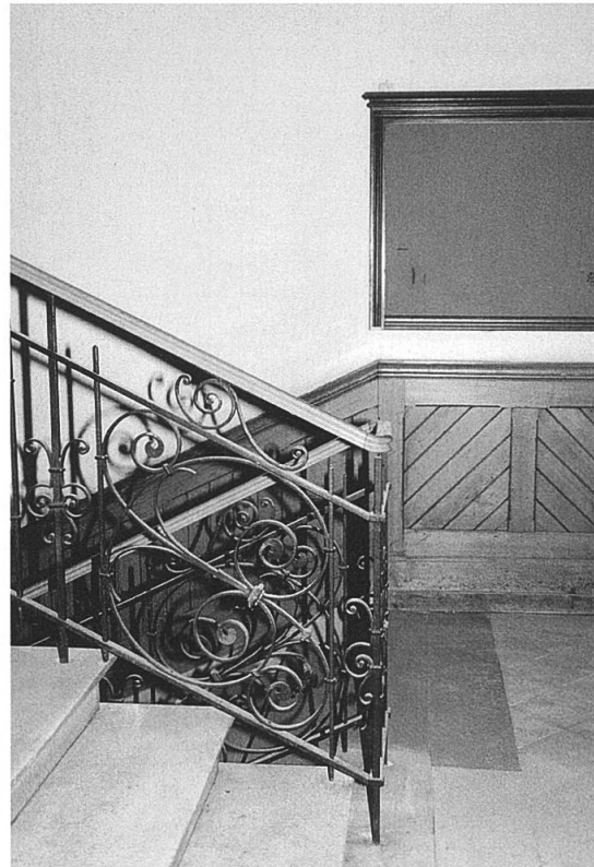
Abb. 60: Haupttreppe, Aufnahme 2000. (E.S.).
