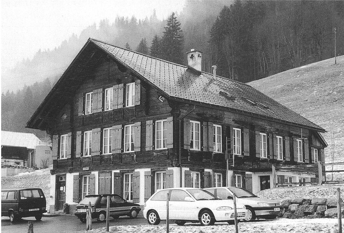
Abb. 134: Ansicht von Süden, Aufnahme 2000. Links im Bild der Haupteingang, der über eine Treppe mit dem laubenartigen Vorraum im Hauptgeschoss verbunden ist. (E.S.).
