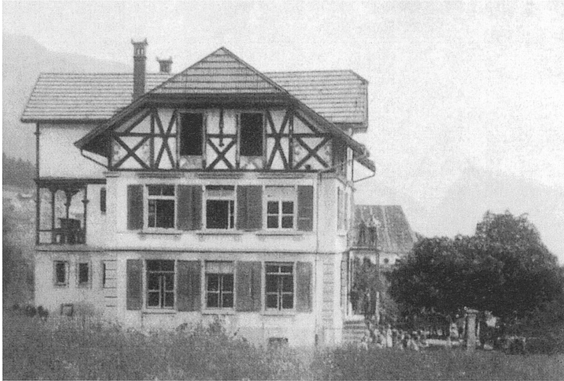
Abb. 98: Ansicht von Südwesten, Zustand vor dem Umbau. Aufnahme vor 1926. (Aus: Frutigen 1985, 7).
