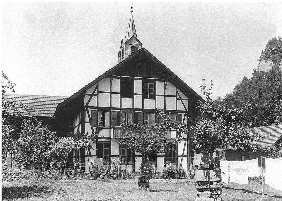
Abb. 119: Ansicht von Süden, Aufnahme um 1940. Auf dem First der Dachreiter mit der Schulglocke. (KDP, Robert Marti-Wehren).
