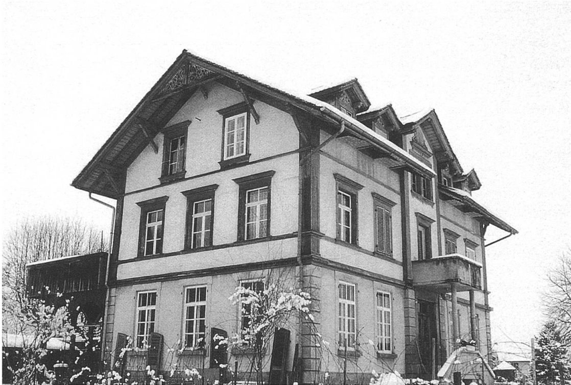
Abb. 137: Ansicht von Südosten, Aufnahme 2000. Die Balkone links im Bild und über dem Haupteingang wurden später hinzugefügt. (E.S.).
